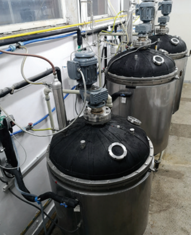
Fot. 1. Instalacja pilotowa do fermentacji metanowej w laboratorium Katedry Inżynierii Procesowej i Technologii Chemicznej
