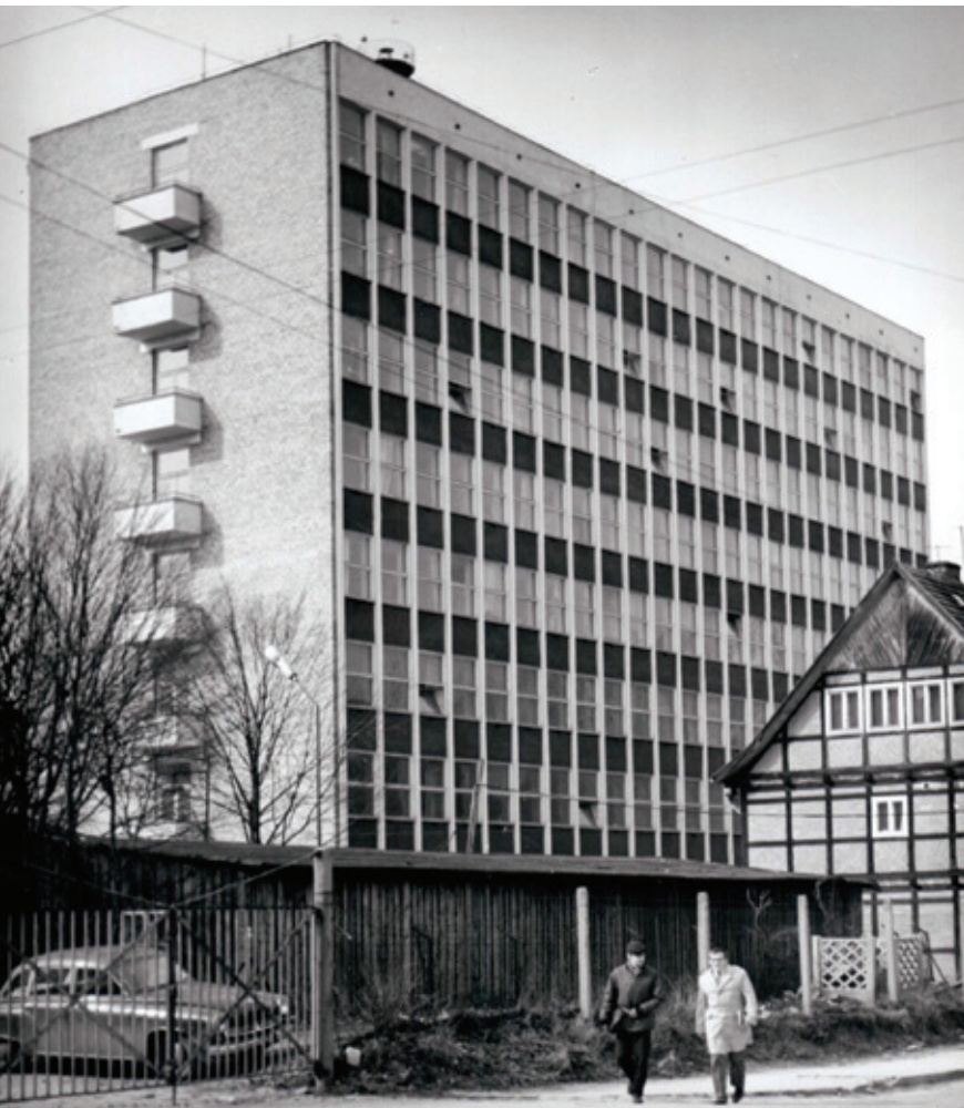
Fot. 2. Budynek Elektroniki, I etap (1969)
