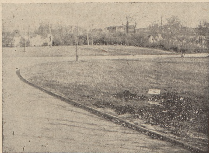
Ryc. 15. Zniszczona strona wklęsła łuku drogi.
