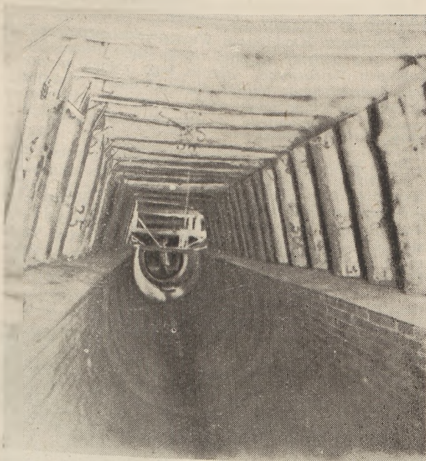
Rys. 1. Budowa głównego kolektora Wielkiej Warszawy. Ramy drewniane górne, część kanału wykonana.
