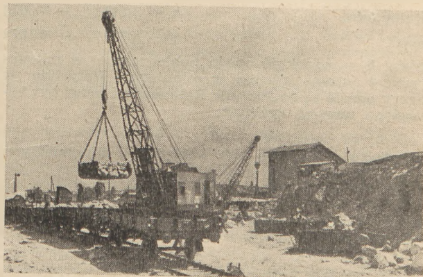
Rys. 5. Ustawianie naładowanych kontenerów na wagony kolejowe.
