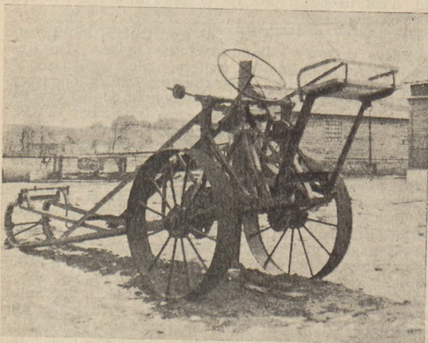
Rys. 9. Pług do kreciego drenowania „C.K.-11”.
