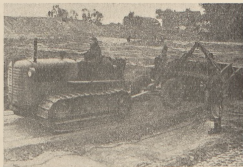
Rys. 9. Zgarniarka o pojemności 6,3 m 3 ciągnięta przez traktor „Stalniec“ S-80.
