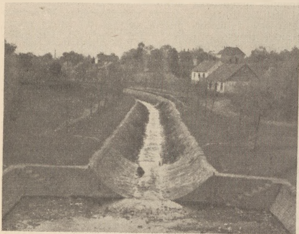
Rys. 2. Potok Mordarka, dopływ prawobrzeżny Łosiny wpadającej lewobrzeżnie do Dunajca, Rynna murowana w Limanowej.
