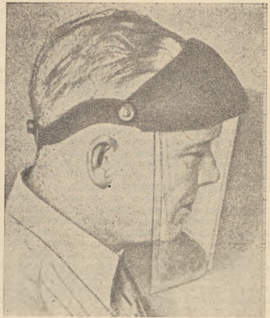
Rys. 7. Przyłbica stosowana przy natrysku lakierów nitrocelulozowych nie spełnia zadania.
