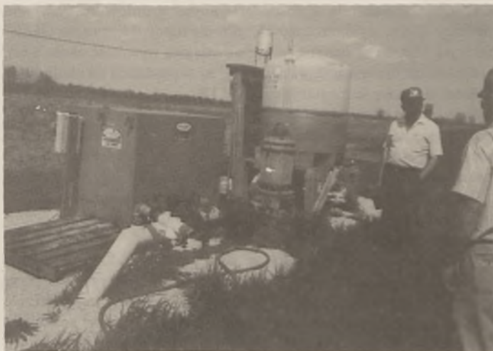
Rys. 15. System pobierania wody z głębokości 40 m oraz sterowane komputerem nawadnianie naziemne upraw ziemniaka. Gospodarstwo doświadczalne Michigan State University, współpracujące ze zrzeszeniem uprawy przemysłowej ziemniaka stanu Michigan (pow. Montcalm)
