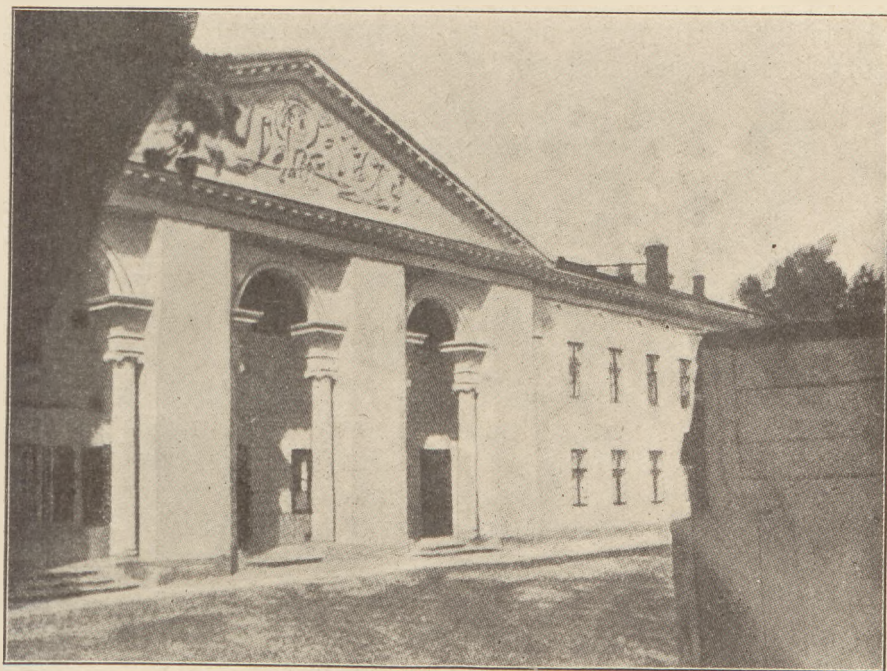
Strażnica mostowa przy ulicy Szerokiej na Pradze
