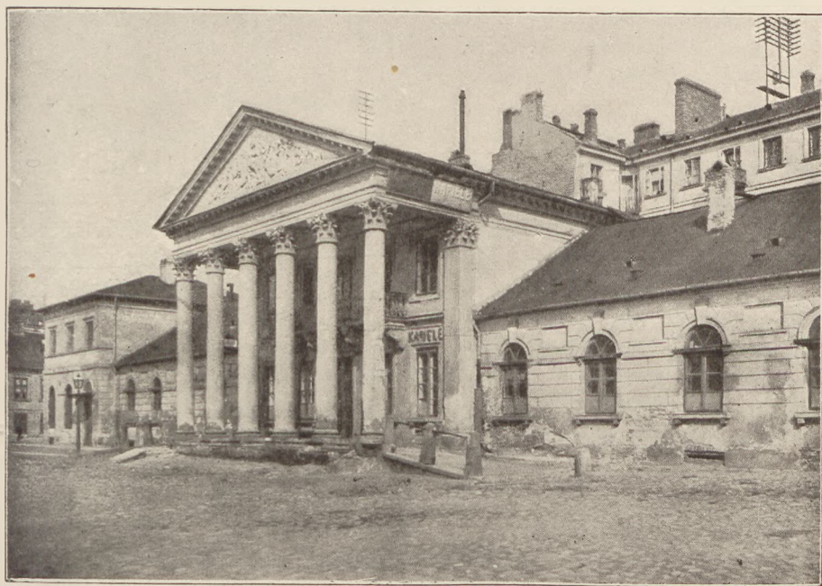
Dawna przymostowa komora wodna przy ulicy Bednarskiej
