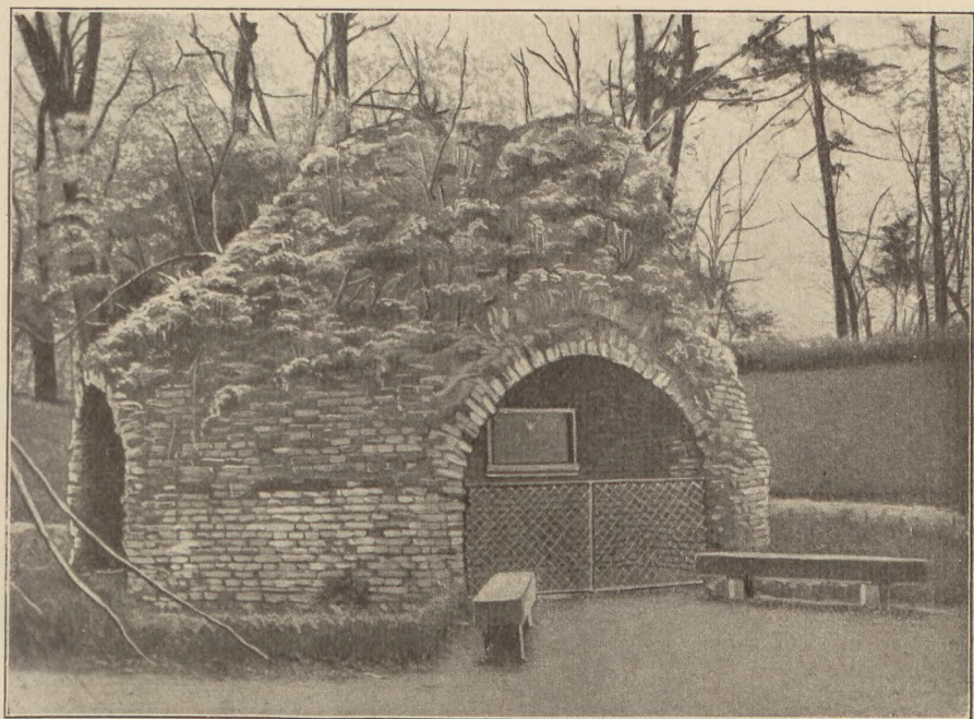
Ruiny fundamentów kościoła Opatrzności w ogrodzie Botanicznym
