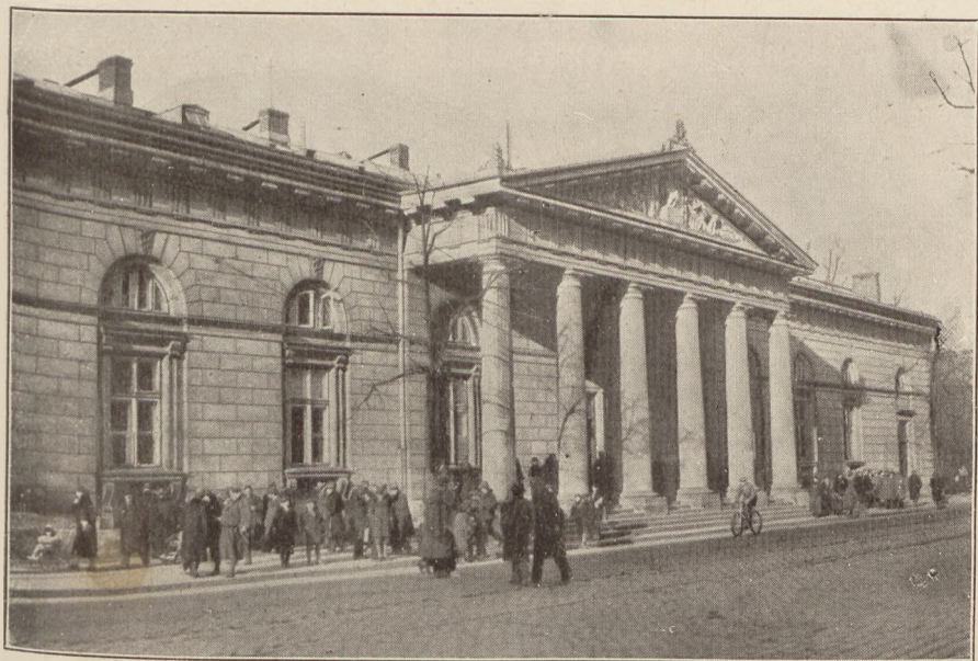
Gmach giełdy, wzniesiony według planów Kubickiego, na miejscu dawnej „Operalni“, obok uliczki Saskiej (fot. H. Poddębski)
