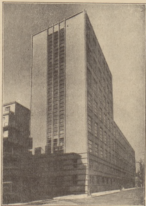
Gmach poczty i telekomunikacji na rogu ul. Poznańskiej i Nowogrodzkiej (fot. Photo-Plat.)
