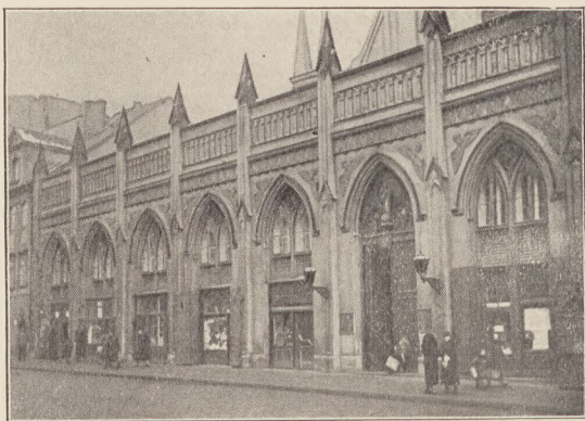
Neogotycka fasada kościoła i b. klasztoru oo. dominikanów przy ulicy Freta (fot. H. Pod- dębski)
