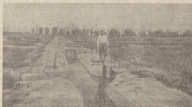
Rys. 3. System nawodniający pól Połotańskiej Stacji Doświadczałnej.
