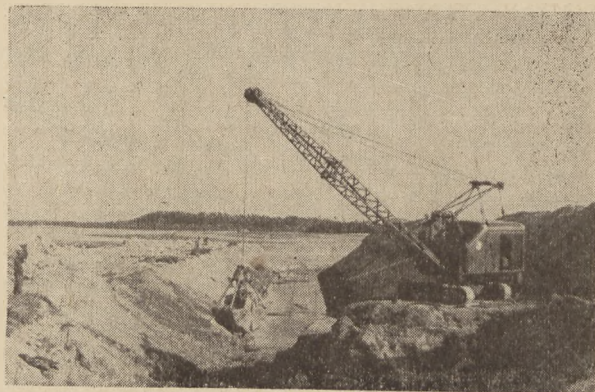
Rys. 2. Postęp skarpowania i umocnień za wykopem koparki.
