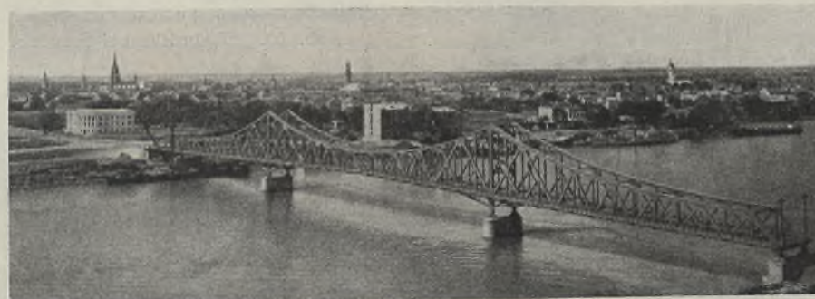
Abb. 17. Straßenbrücke über die Donau zwischen Novi-Sad und Peterwardein.
