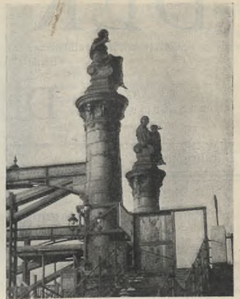
Abb. 5. Pylonen der alten Brücke.
