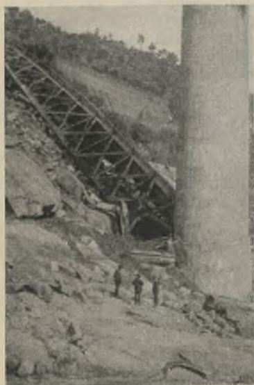
Abb. 3. Herabgestürzter Überbau.
