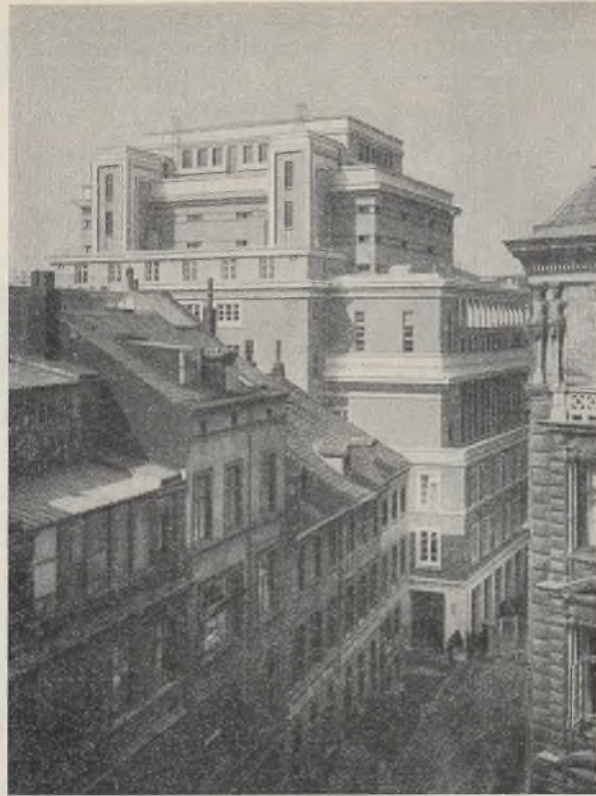
Abb. 9. Ansicht des fertigen Bauwerks.
