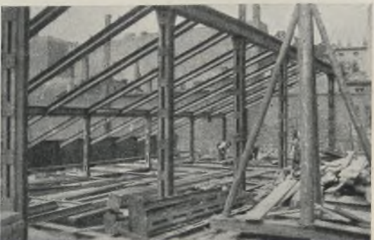
Abb. 9. Montage des Ranges.
