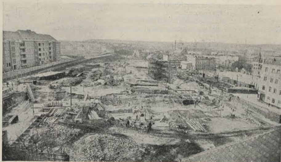
Abb. 9. Übersicht über die Baustelle.
