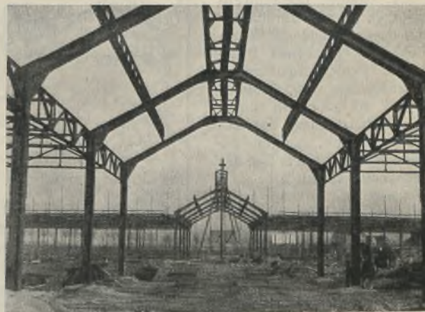
Abb. 3a. Aufstellung des Portaltragwerks für den Längsgang (vergl. Abb. 3).
