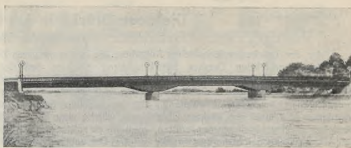
Abb. 2. Die neue Brücke.
