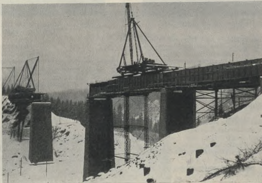
Abb. 2. Wettera-Brücke. Zusammenbau der Hauptträger.
