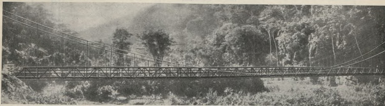
Abb. 1. Gesamtansicht der versteiften Hängebrücke von 108,68 m Spannweite.
