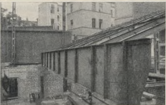
Abb. 8. Der Rangendquerträger.
