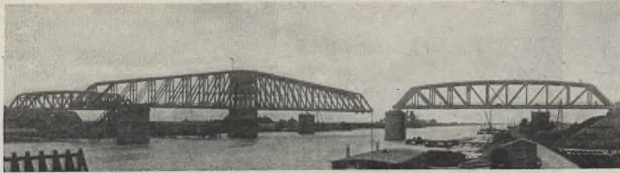
Abb. 12. Eisenbahndrehbrücke bei Zaandam.
