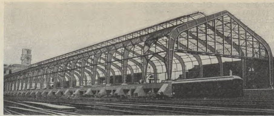
Abb. 21. Bahnhofshalle São Paulo (Brasilien).
