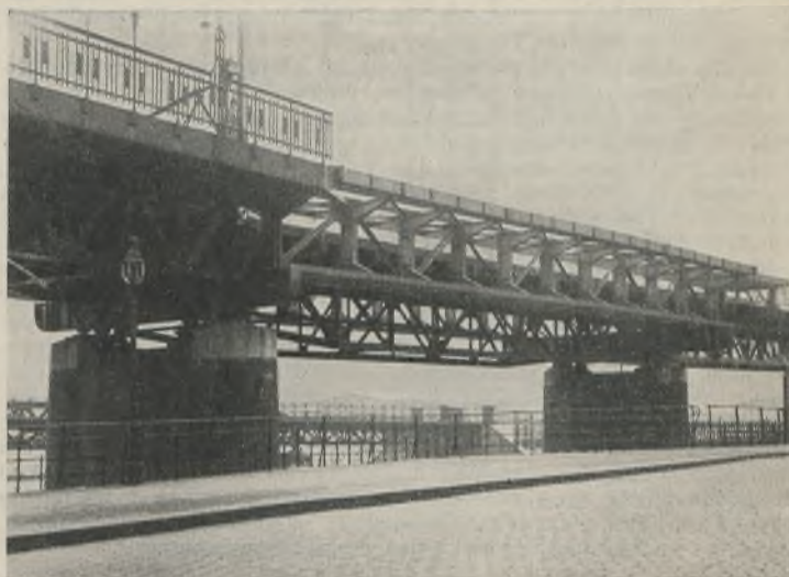
Abb. 28. Fertig eingebaute dreiflächige Gitterträger ohne Bahnsteigplatte.
