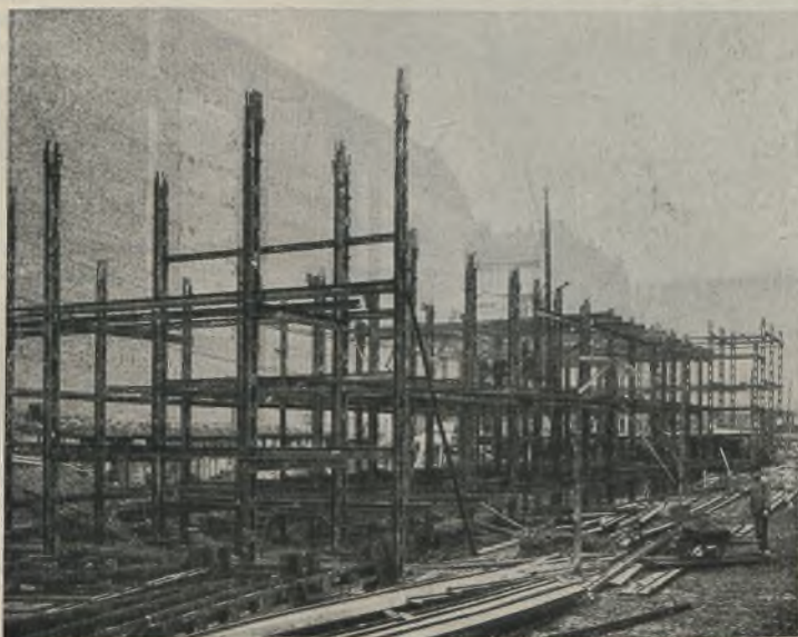
Abb. 1. Stahltragwerk für den Wohnhausblock Agricola-, Tile-Wardenberg-Straße in Berlin NW.
