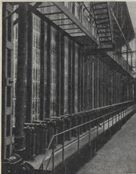
Abb. 2. Vertikalkammer-Ofenanlage des Gaswerkes Charlottenburg.
