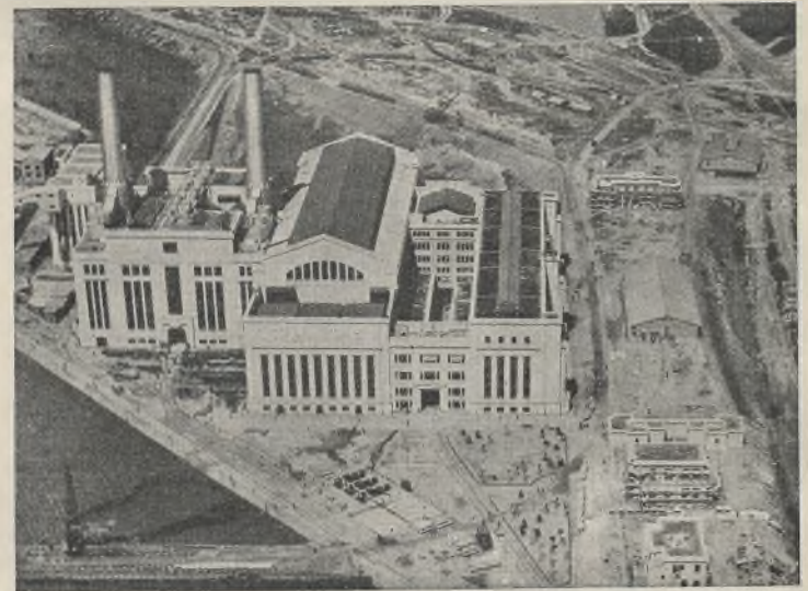
Abb. 16. Fliegeraufnahme der Gesamtanlage des Kraftwerkes Chade.
