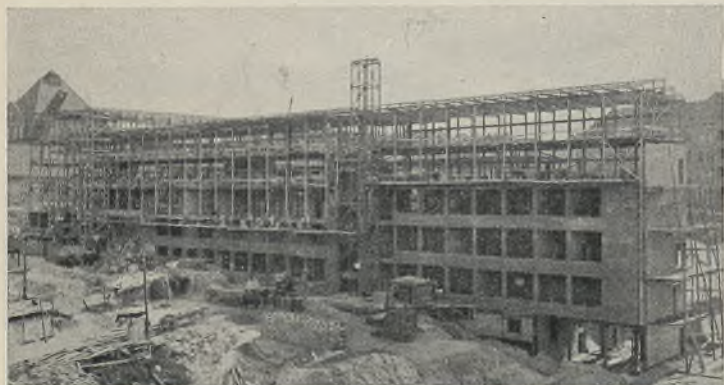
Abb. 12. Die Fachschule III während der Ausmauerung.
