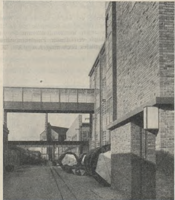
Abb. 34. Ansicht von Straße 10 (s. S. 117).
