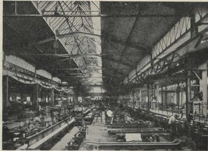
Abb. 6. Innenansicht der Werkstättenhalle.
