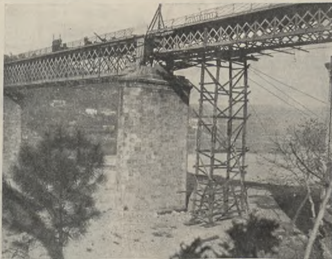
Abb. 9. Ansicht der in Wiederherstellung befindlichen Brücke.
