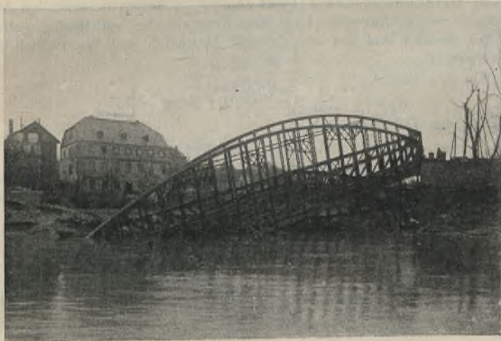
Abb. 1. Die Brücke nach dem Einsturz des nördlichen Widerlagers.
