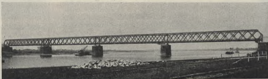
Abb. 15. Zweigleisige Eisenbahnbrücke bei Wesel.
