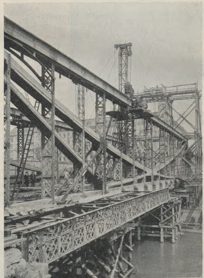
Abb. 18. Das provisorische Zugband ist eingeführt, die untere Kette ist durchschnitten.
