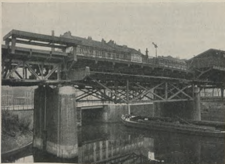
Abb. 27. Rüstung des Bahnkörpers mittels zweier an die fertigen Auflagerträger angehängten Sprengwerke.
