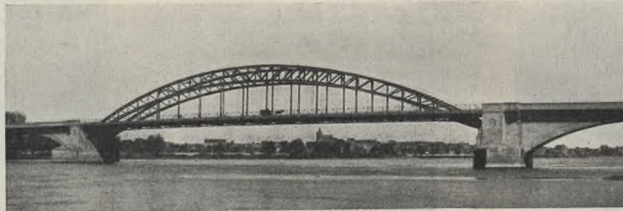
Abb. 14. Straßenbrücke über die Oder bei Fürstenberg.
