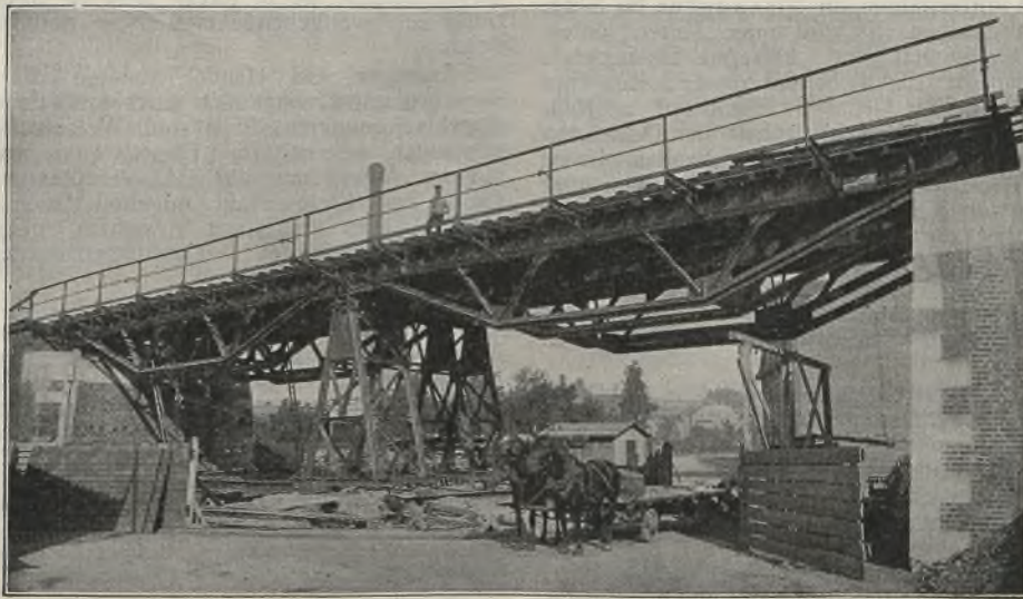
Abb. 8. Die neue Brücke unmittelbar nach ihrer Fertigstellung.
