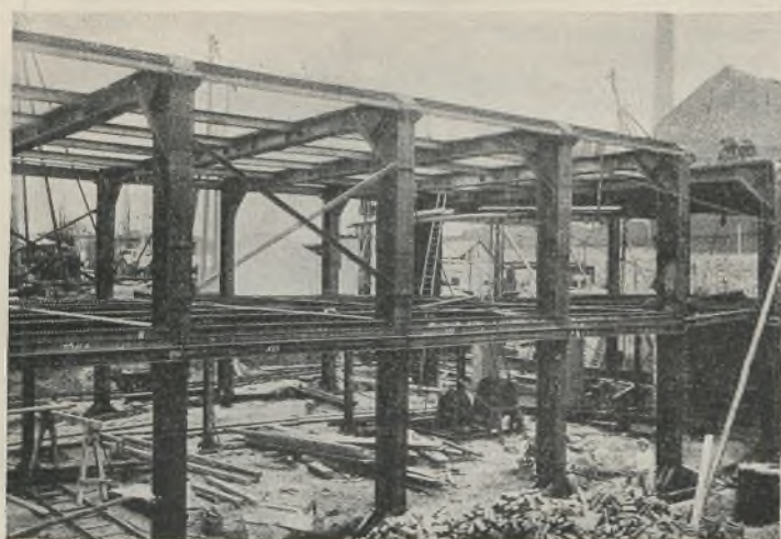
Abb. 5. Montage des untersten Rahmens.
