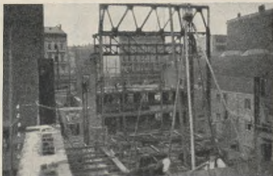
Abb. 6. Montage des Gitterträgers über der Bühne.
