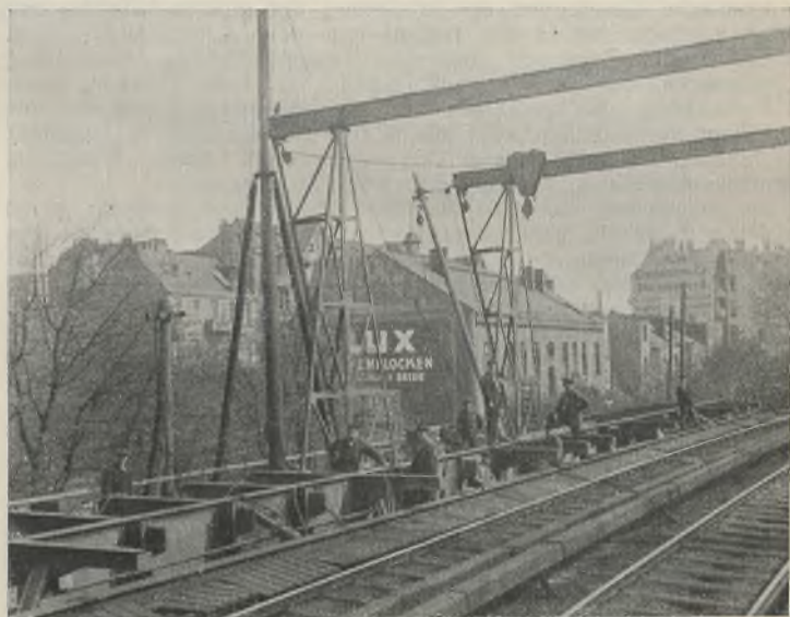
Abb. 26. Versetzen der Querträger mittels fahrbarer Portalkrane.
