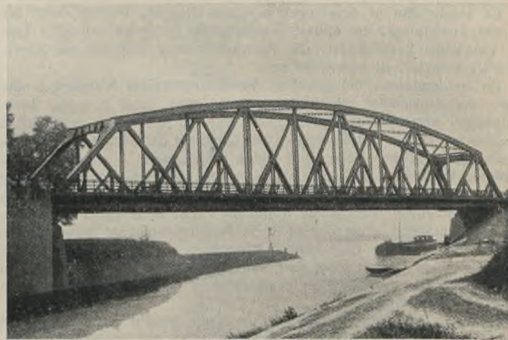
Abb. 2. Die Brücke mit neuem Überbau.
