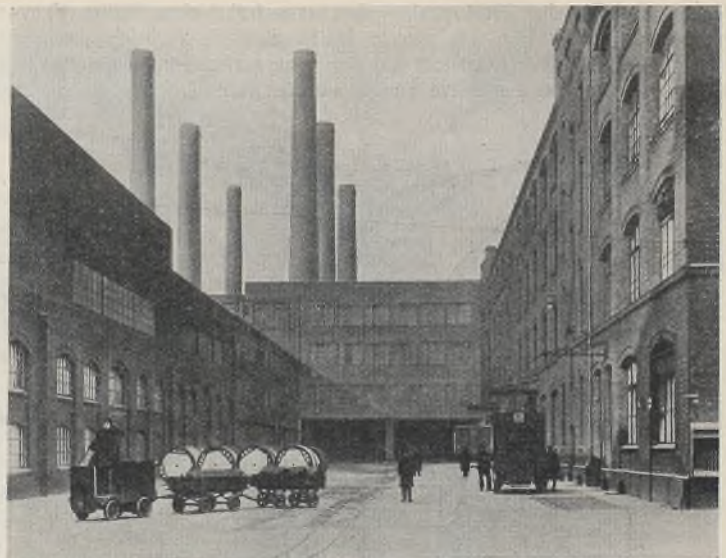
Abb. 11. Straße 4 (Block I) neuer Zustand.
