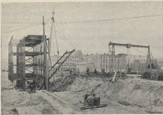
Abb. 10. Aufrichtung eines Rahmenfeldes.
