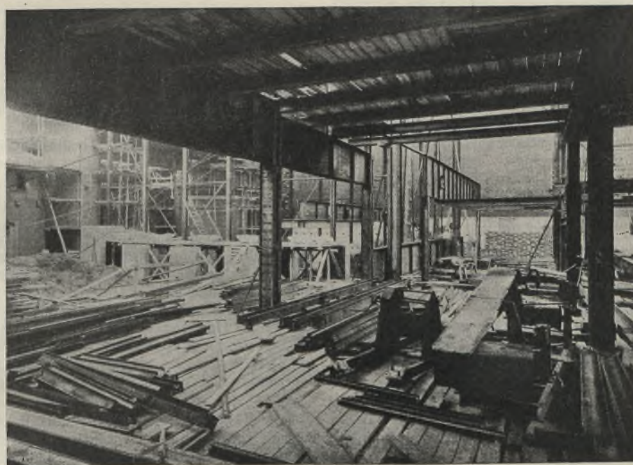
Abb. 11. Unterzüge im Geschäftshaus, im Hintergrund die Rangkonstruktion.
