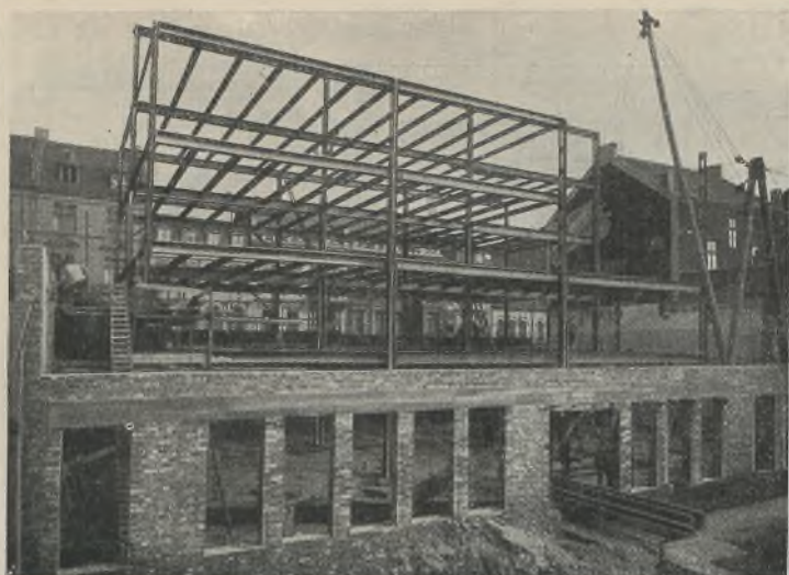
Abb. 5. Stahlskelett fast fertig. Hofseite.
