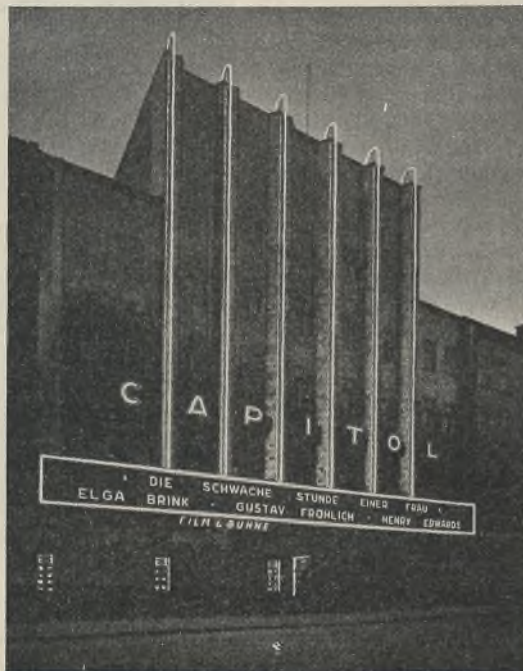
Abb. 1. Hauptfront bei Abendbeleuchtung.
