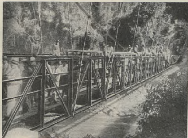
Abb. 2. Der fertige Versteifungsträger.
