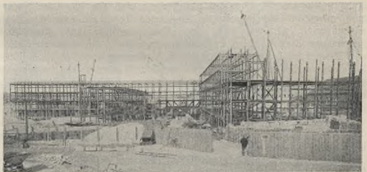
Abb. 14. Ansicht der Fachschulbaukörper I bis III während des Baues.
