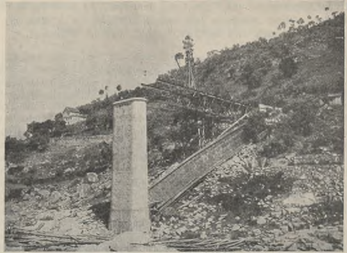
Abb. 5. Freivorbau des neuen Seitenüberbaues: Seilbahn, alte zerstörte Brücke.
