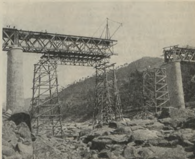
Abb. 6. Vorbau des neuen Mittelüberbaues.
