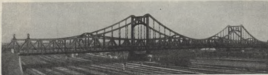
Abb. 13. Hindenburgbrücke über den Bahnhof Halle a. d. S.
