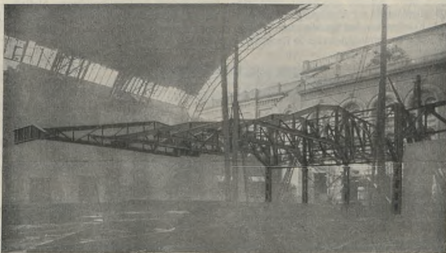
Abb. 6. Kragträger der Rangkonstruktionen in der Aufstellung.
