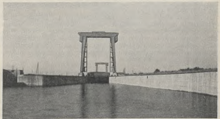
Abb. 3. Hubtore der Schleusen des Lippe-Seitenkanals.
