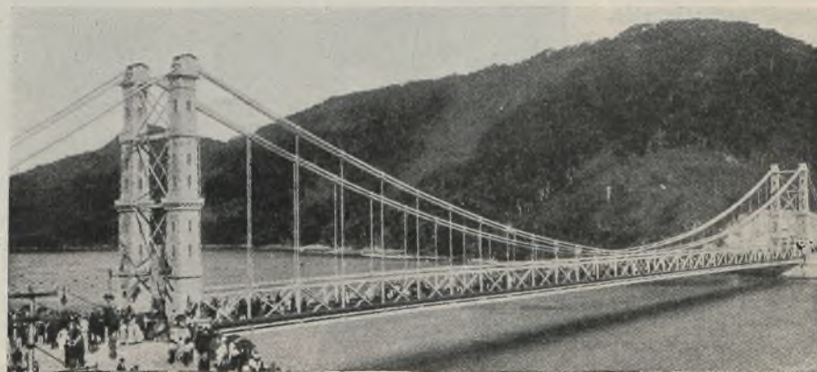
Abb. 11. Kabelhängebrücke über einen Meeresarm bei Santos in Brasilien.
