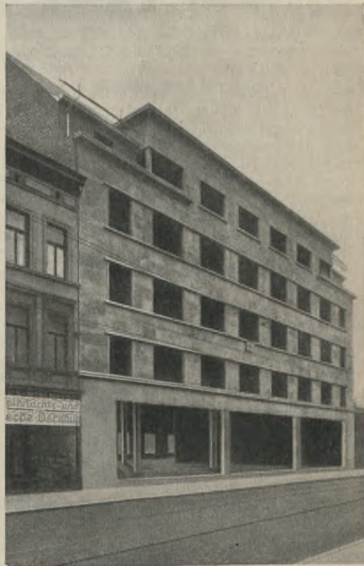
Abb. 2. Ansicht des fertigen Bauwerks mit ausgemauertem Stahlskelett.
