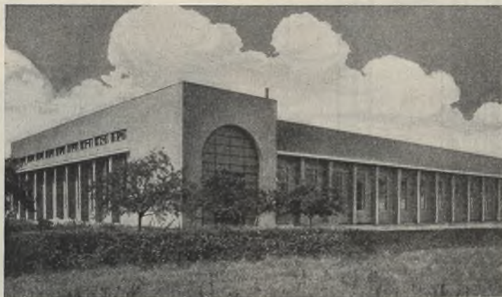
Abb. 3. Außenansicht der Montagehalle.
