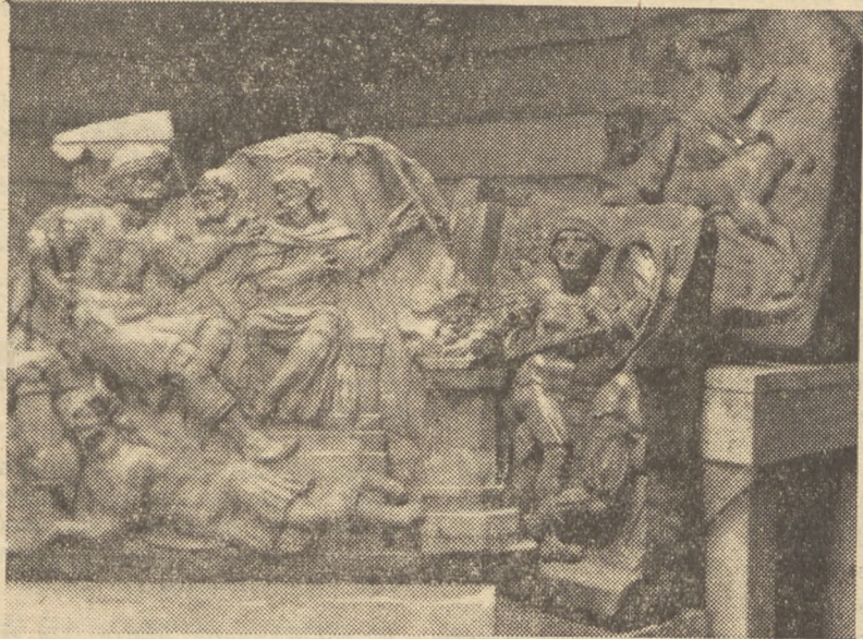
Gdańsk — Dom Steffensa; naprawa uszkodzonych płaskorzeźb fasady
