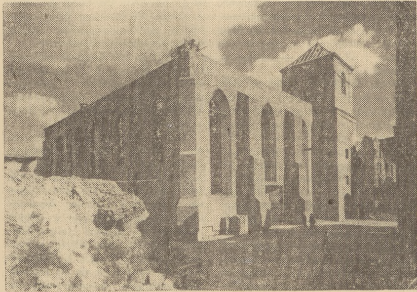
Katedra Św. Jana w Warszawie w czasie odbudowy fot. Cz. Olszewski
