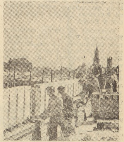
Uczniowie Technikum Kamieniarskiego przy montażu attyki na M.D.M.
