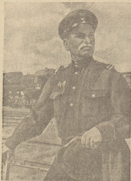
Starszy zwrotniczy stacji Kalinin, Piotr Filipow, który przez całe swoje życie pracował przy ręcznych zwrotnicach, przekazał swą pracę automatycznej centrali. Obecnie jest on zasłużonym zwrotniczym Kolei Państwowej i kieruje sełkami zautomatyzowanych zwrotnic
