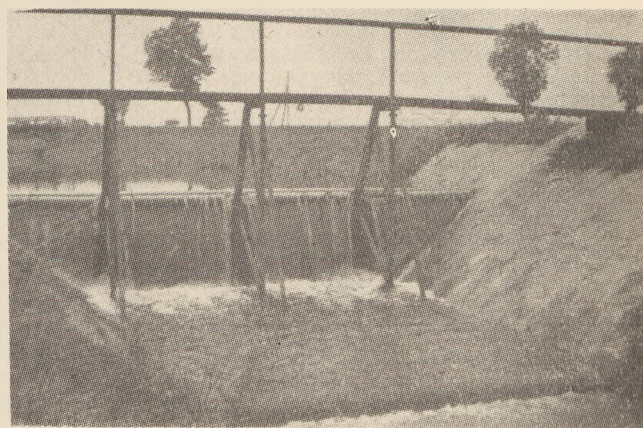
Rys. 1. Jaz bezprzyczółkowy piętrzący wody Samnicy
