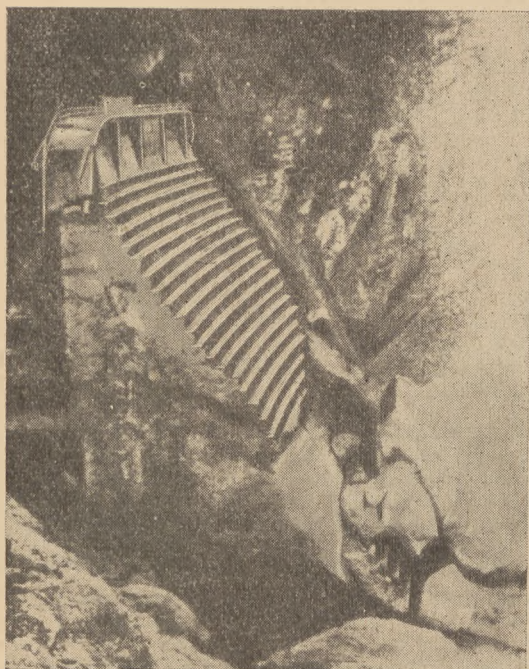
Rys. 1. Zapora St. Francis po katastrofie
