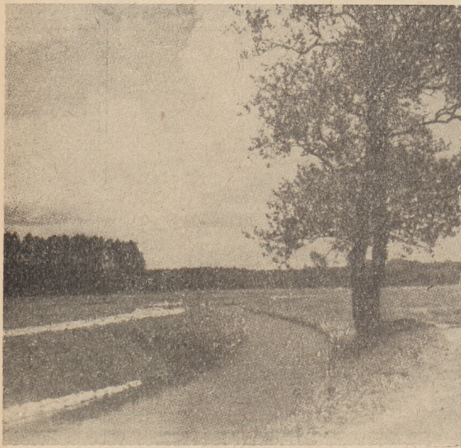
Rys. 8. Właściwe wykorzystanie istniejącej roślinności przy trasowaniu koryta mniejszej rzeki w związku z jej regulacją. Prawy brzeg opiera się o istniejące drzewo, a lewy o zarośla wikliny
