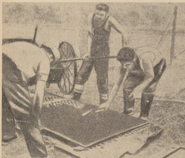
Rys. 5. Przygotowywanie małych mat bitumicznych
