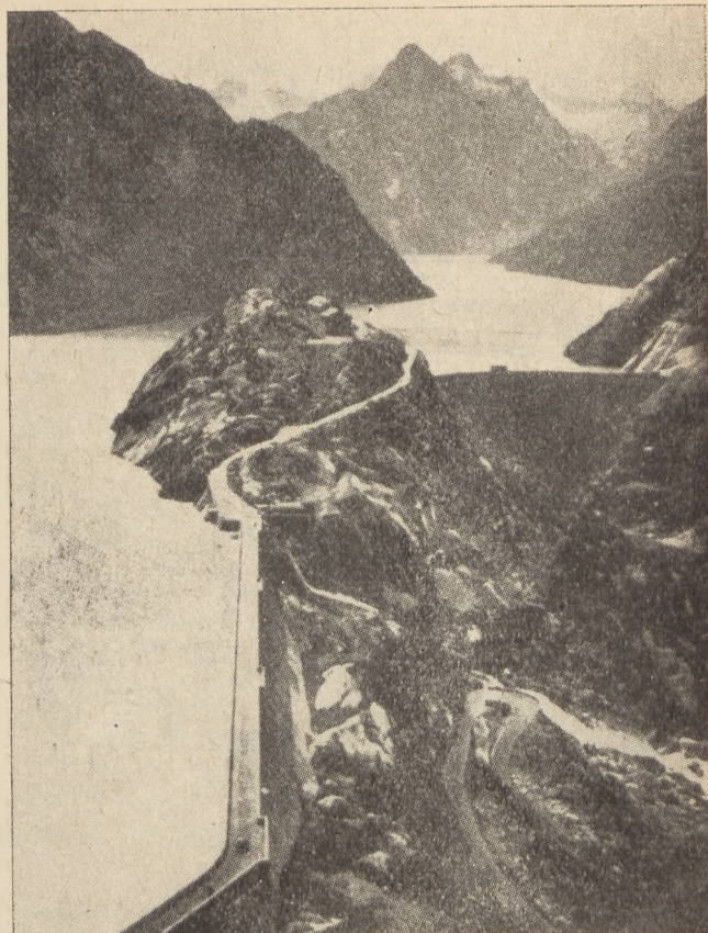
Rys. 4. Zbiornik Grimsel: na pierwszym planie zapora Secufereg, w tle zapora Spitalamm.
