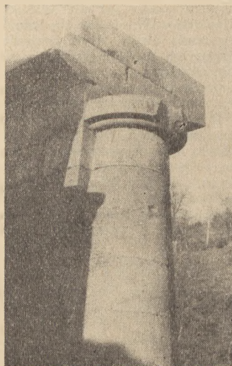
Rys. 2. Brody fabryczne. Rzeka Kamienna, detal filtra upustu
