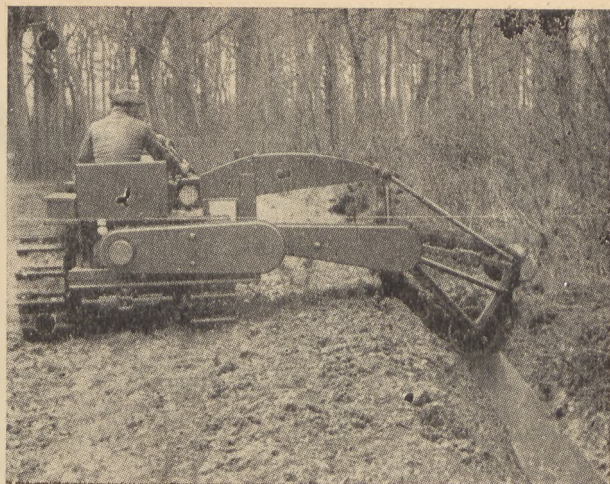
Rys. 8. Angielska koparka do kopania rowów
