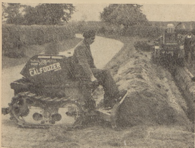
Rys. 7. Specjalna koparka do kopania rowków drenarskich i spycharka, produkcji angielskiej przy pracy w zespole
