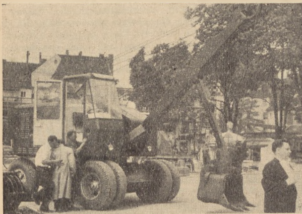
Rys. 1. Polskiej konstrukcji koparka przedsiębierna, o pojemności łyżki 0,25 m 3 , produkcji Z. B. U. P. im. L. Waryńskiego w Warszawie
