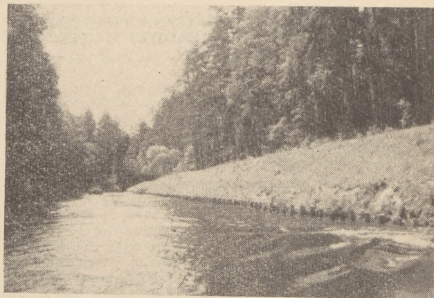
Rys. 4. Skarpa kanału ubezpieczona płotkiem (fot. inż. F. Niczkie)
