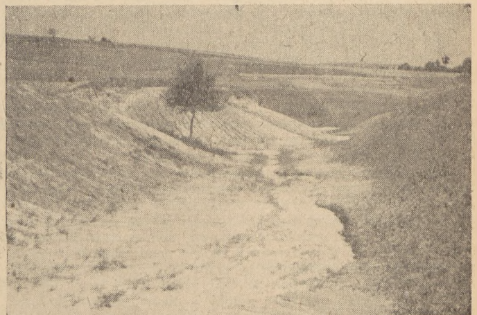
Rys. 13. Próby wyrównania dawnego parowu. Mimo krótkich zboczy gleba została zmyta, a dno zamulone piaskiem. Owies zasiany na jałowej ziemi nie dał głębie żadnej osłony.
