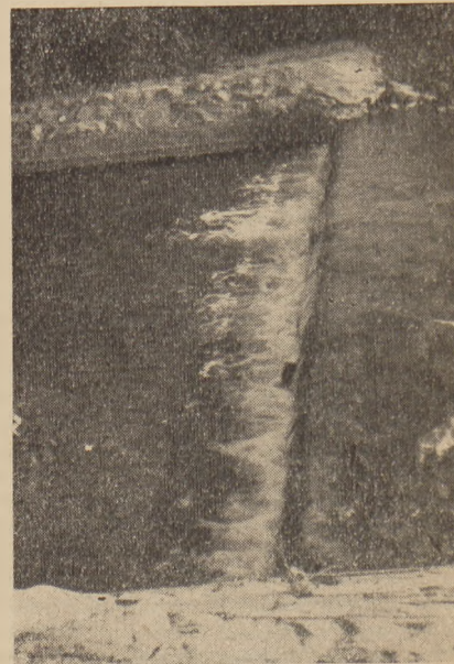
Rys. 3. Progi kamienne wykonane jeszcze w zarządzie austriackim na rzece Białej pod Grybowem. Dzięki konserwacji utrzymują się dobrze
