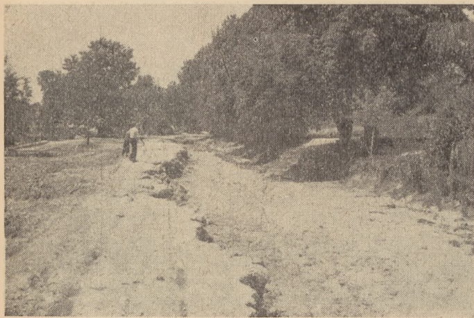
Rys. 6. Zniszczony odcinek szosy w środkowej części wsi. Osoba widoczna na fotografii stoi na lewej pozostałej krawędzi szosy.
