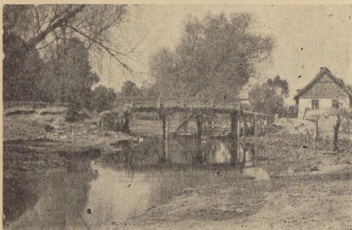
Rys. 3. Most drogowy we wsi Ostrzyca. Z obu stron mostu widoczne są rozmycia nasypu drogowego. Koryto ciekła tu pokazane znajduje się poniżej mostu. Jest ono rozmyte i do 3 razy szersze niż powyżej mostu. Z prawej strony w głębi widoczny budynek był zatopiony do połowy wysokości okien.
