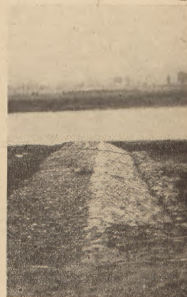
Rys. 5. Nowe tamy poprzeczne i równoległe na Dunajcu w rejonie wsi Rozłoki. — Stan dobry
