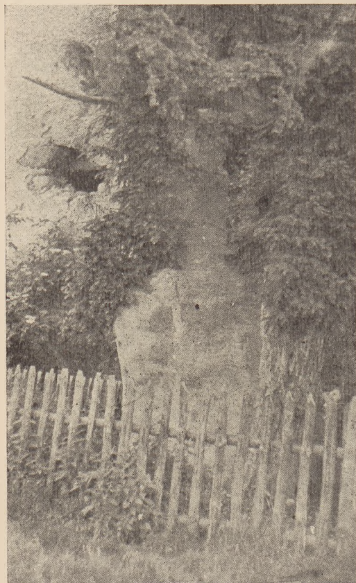
Ryc. 3. Cis w Henrykowie. Zdjęcie dolnej zacementowanej części pnia
