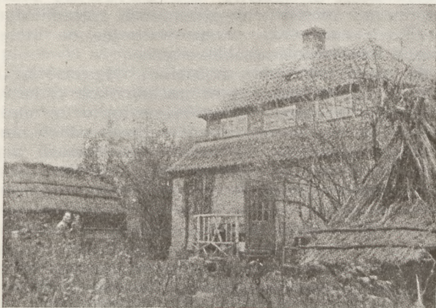
Ryc. 1. Budynek stacji ornitologicznej na wyspie Mętnej pod Szczecinem
