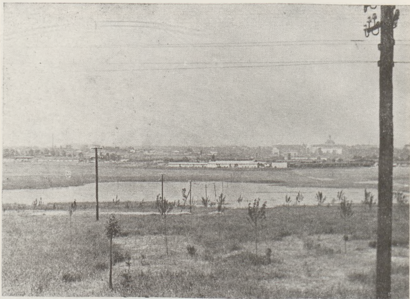
Ryc. 2. Na przedmieściach Katowic zapadają się grunty położone ponad kopalniami. Stopień dotychczasowego obniżenia się ziemi poznać po zaburzeniu słupów telegraficznych w wodzie
