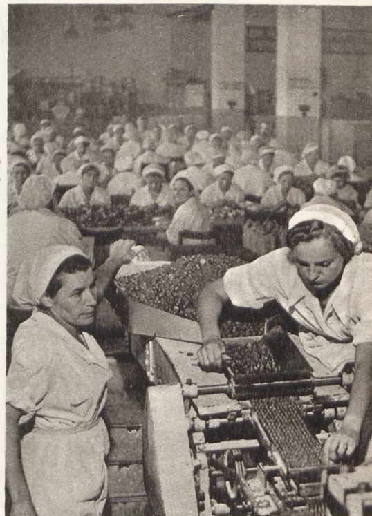
Mechanische Verpackung von Hartbonbons. Im Hintergrund: Verpackung im Handverfahren
