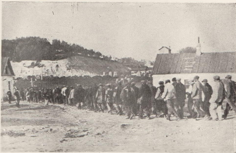
2000 Żydów z obozu w Słupkach koło Tarnopola pracowało przy budowie linii kolejowej
