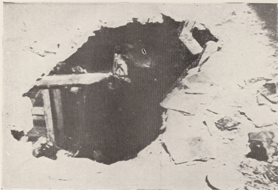
Bunkier, który spalono wraz z jego mieszkańcami
