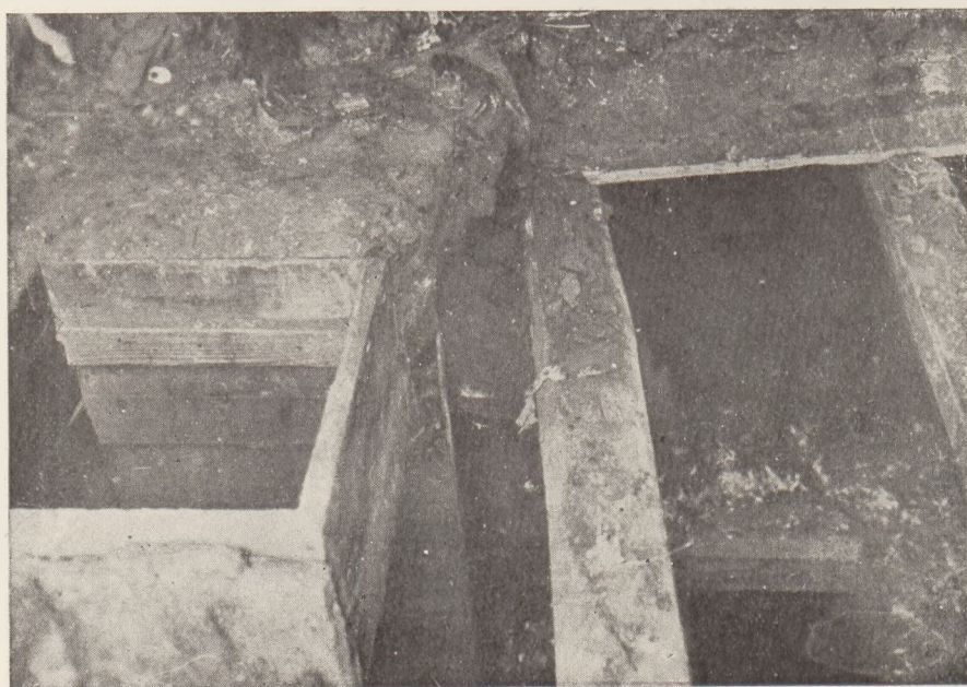
Wejście do bunkra przez otwór w ścianie piwnicy
