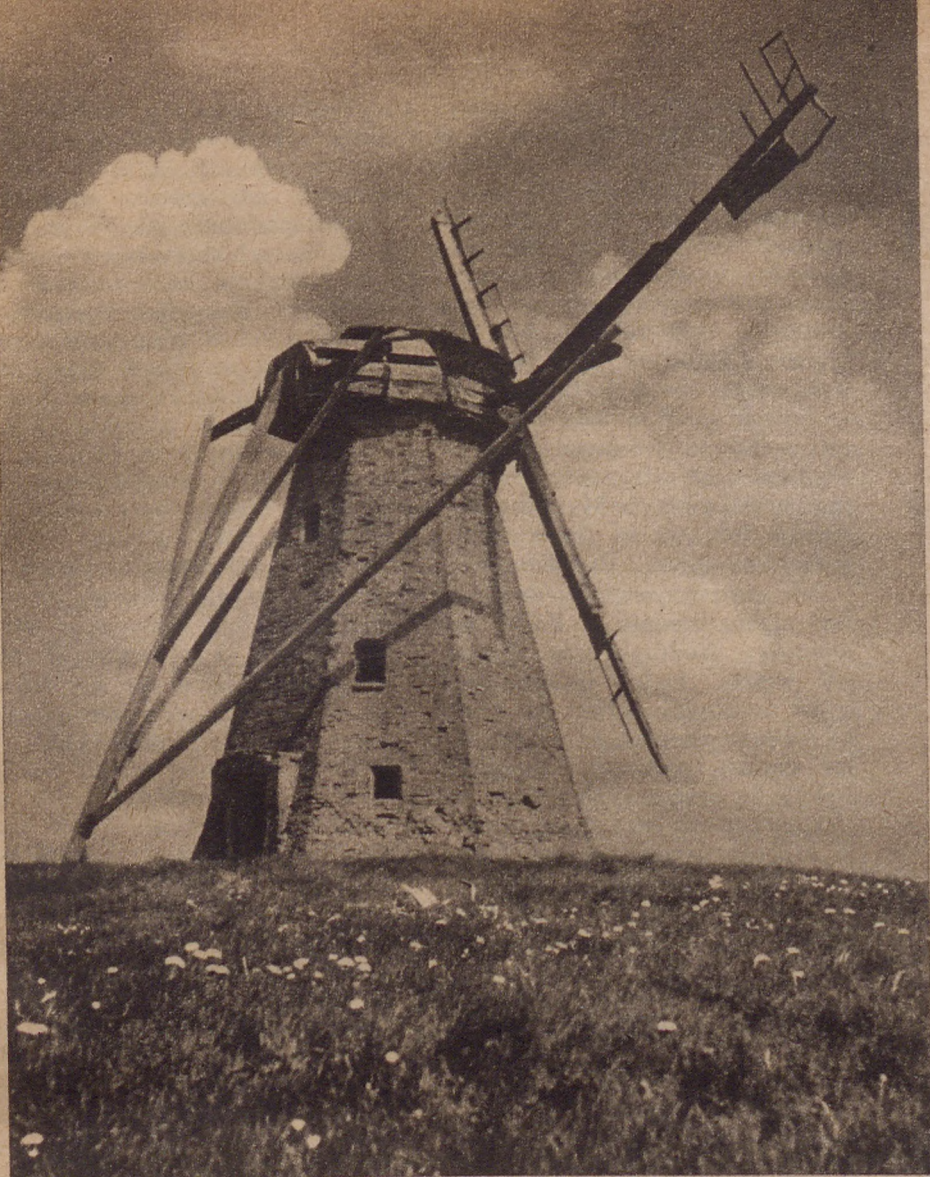
1 Wiatrak typu holenderskiego w Buczniku w pow. wąbrzeskim jeden z ostatnich zabytków tego rodzaju, niedawno przeznaczony na rozbiórkę.
