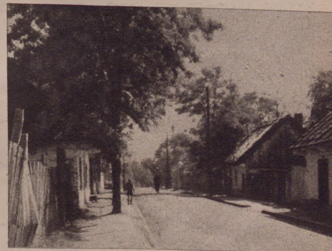
Ulica Fabryczna w Koniecpolu, przy której mieściła się walcownia. Na pierwszym planie planie domy robotnicze.
