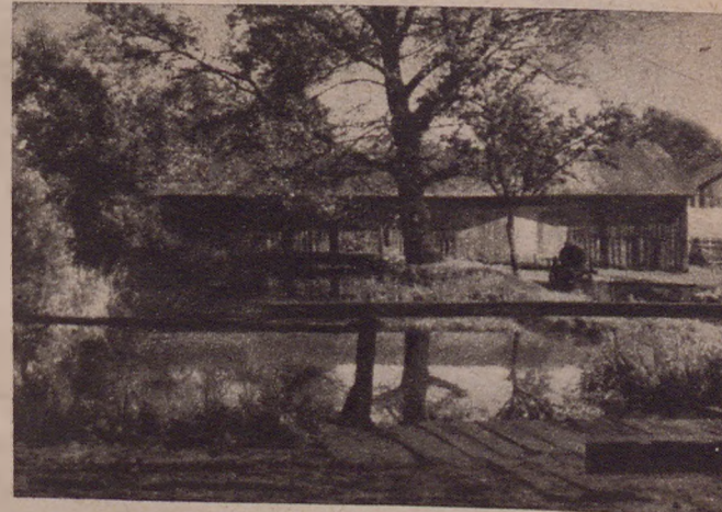
Szopa w której mieściła się gwoździarnia. Widoczny na zdjęciu kanał doprowadzał wodę do koła.
