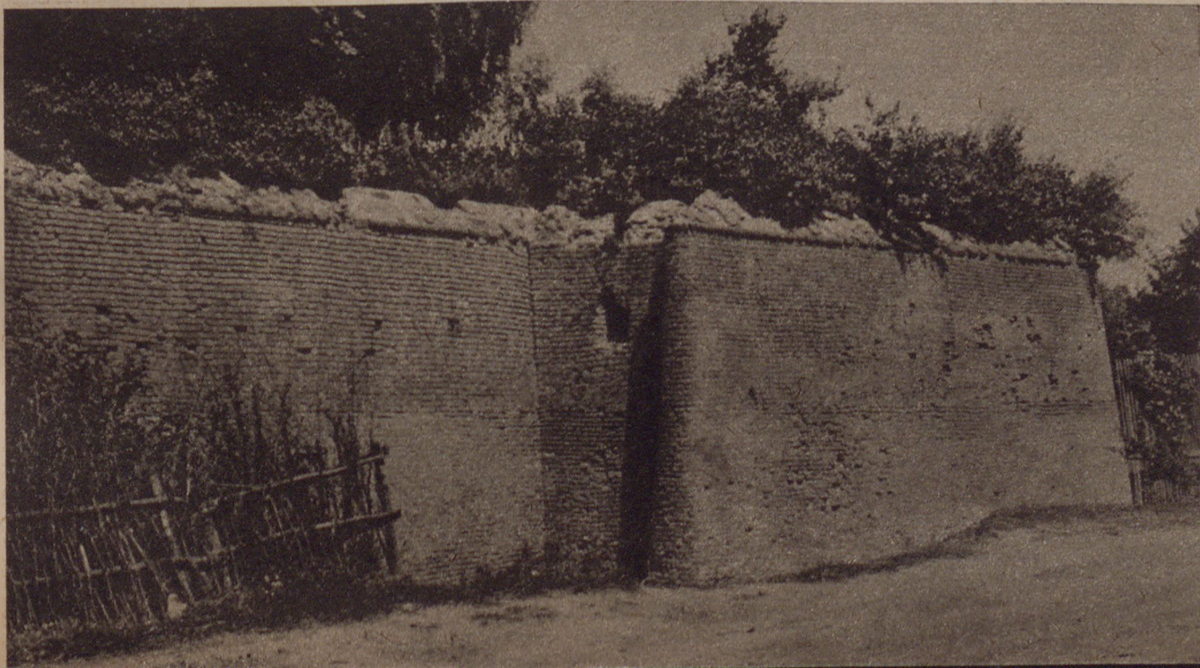
3 Strzelnica barku i tzw. orion bastionu Wysokiego, element niezwykle rzadko spotykany w fortyfikacjach polskich.
