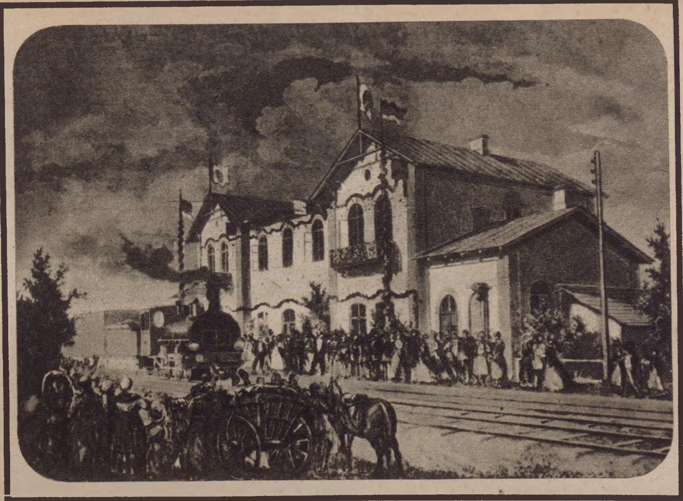
Dworzec „Drogi żelaznej warszawsko-terespolskiej” w Siedlcach. Rycina z Tygodnika Ilustrowanego z r. 1866 przedstawia moment wjazdu pierwszego pociągu z Warszawy.
