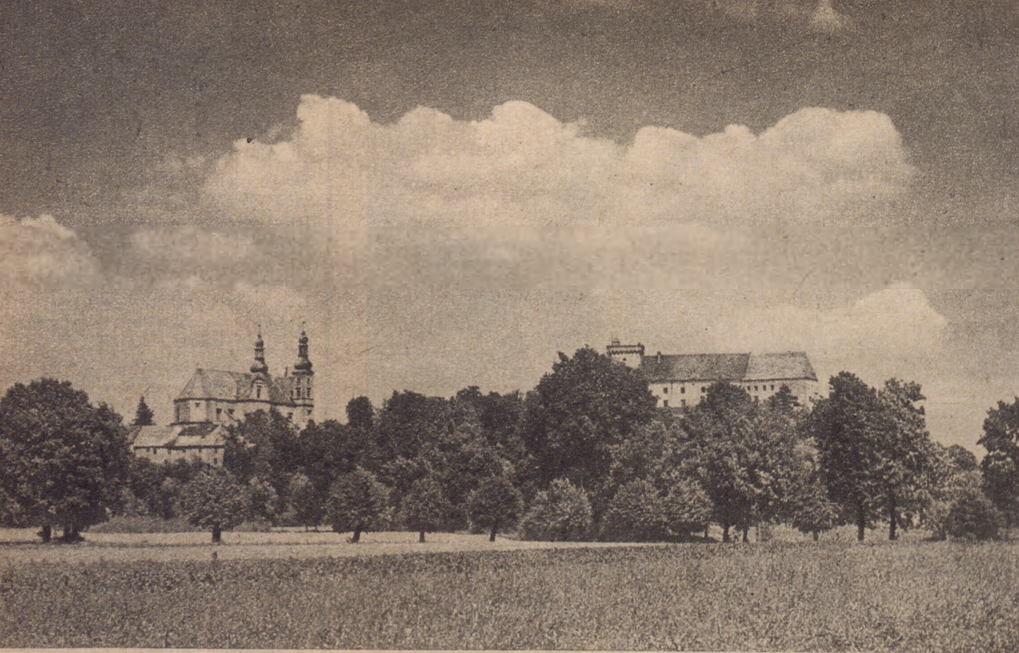
Z lewej: panorama Otmuchowa. Fot. T. Chrzanowski. Z prawej: otoczona rusztowaniem wieża znajdującego się w odbudowie ratusza otmuchowskiego. Fot. W. Plewiński.
