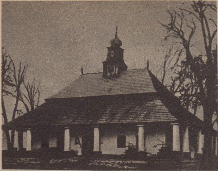
Zbudowany w początkach XIX wieku ratusz sławkowski, zniszczony po roku 1916. Zdjęcie archiwalne.
