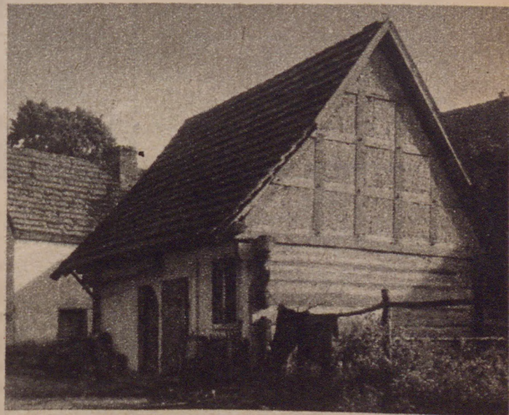
Drewniana chata z szachulcowym szczytem we wsi Brzezinka, powiat kluczborski. Fot. Tadeusz Chrzanowski. Poniżej: napis nad wejściem do lamusa w Brzezince.
