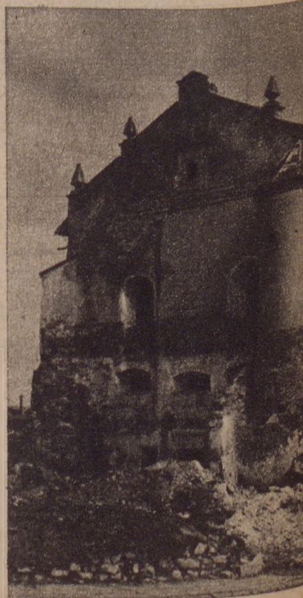
Fragment elewacji zachodniej po częściowym wyburzeniu. Fot. G. Faryaszewska
