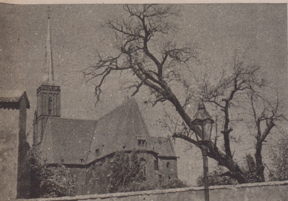
Poniżej: XIII-wieczny kościół św. Krzyża we Wrocławiu, odbudowany ze zniszczeń wojennych.
