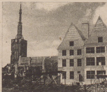
Powyżej: Elbląg. Odbudowa Starego Miasta.
