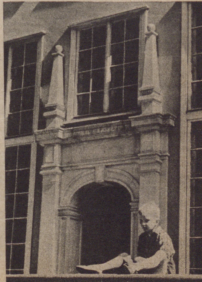
Portal odrestaurowanej kamieniczki w Gdańsku.
