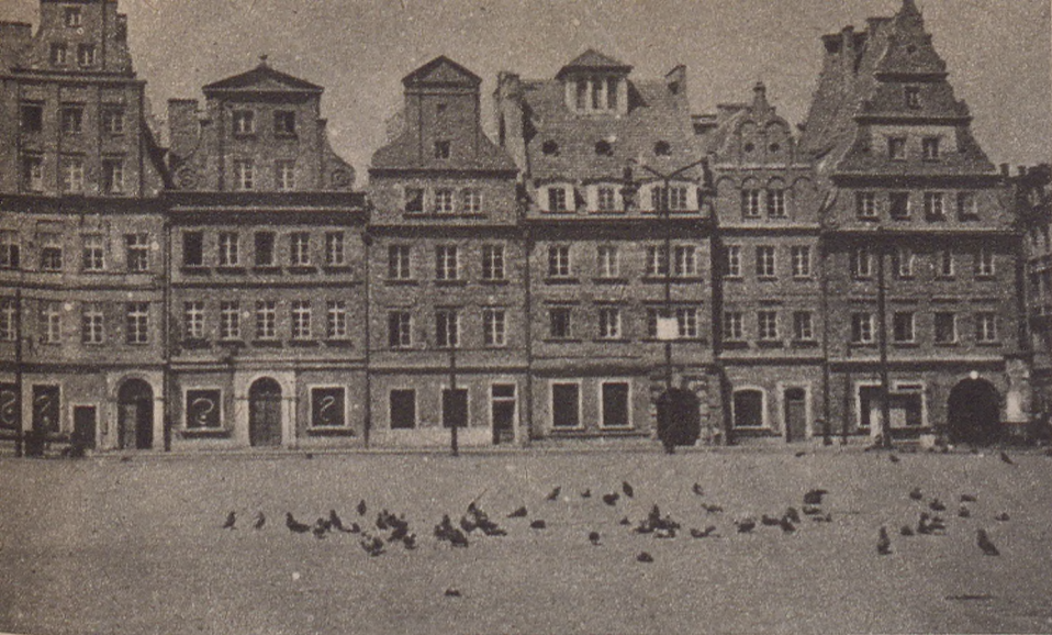
Powyżej: Wrocław. Odbudowane od podstaw kamieniczki na Placu Solnym.
