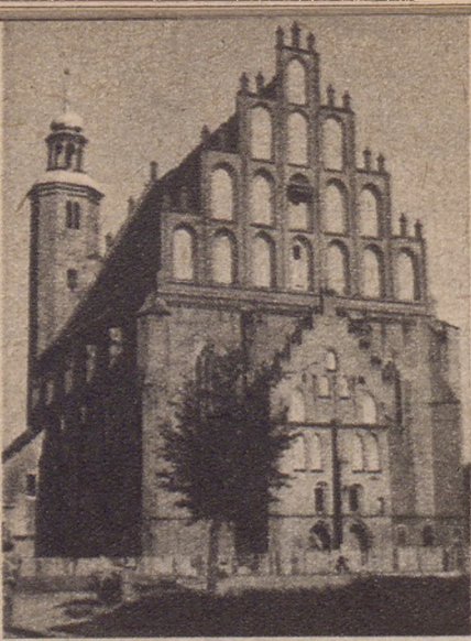
Zary. Odbudowany kościół gotycki.
