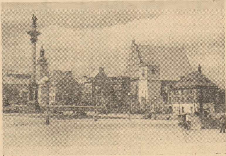
U wejścia na Trakt Starej Warszawy
