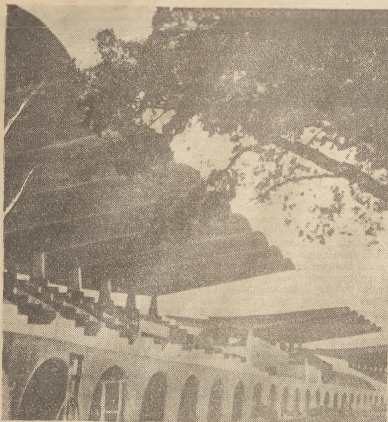
Współczesne poczucie statyki: nie ma obawy; tej konstrukcji nie trzeba podtrzymywać murami z cegieł. Stadion w Madrycie — projektował Torroja
