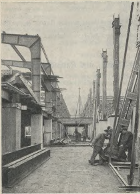
Abb. 11. Montage der Stützen.
