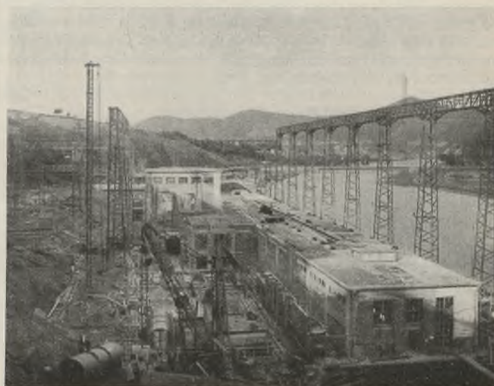
Abb. 2. Freiluftschaltanlage Bringhausen. Montage der zweiten Stützenreihe.
