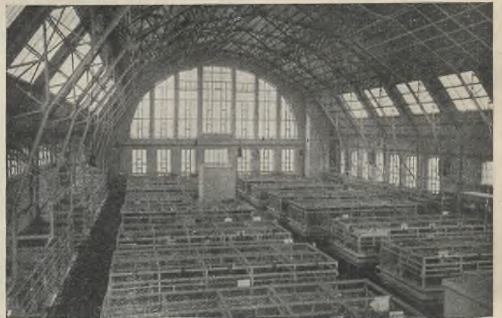
Abb. 4. Innenansicht der Markthalle.
