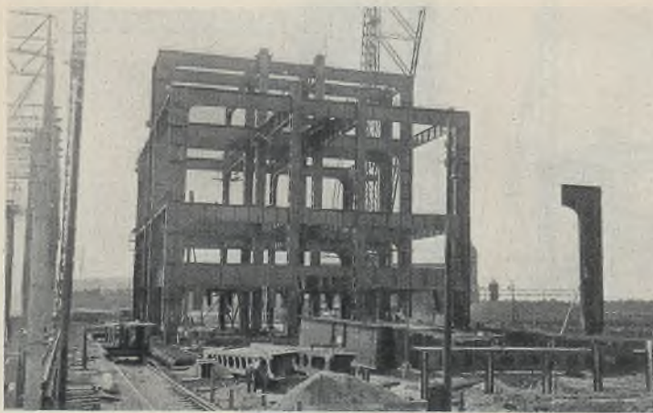
Abb. 19. Südliche Hälfte, 3. Geschoß im Bau. 18. August 1929.
