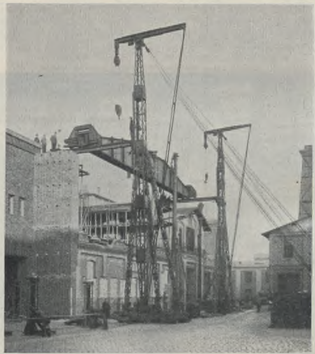
Abb. 11. Binder auf die Fahrbahn hinuntergelassen.
