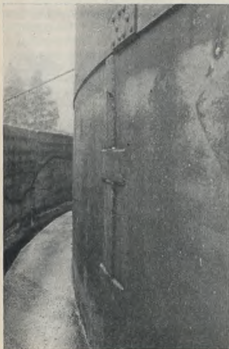
Abb. 3. Schweißnaht und Verlaschung an der Außenseite.
