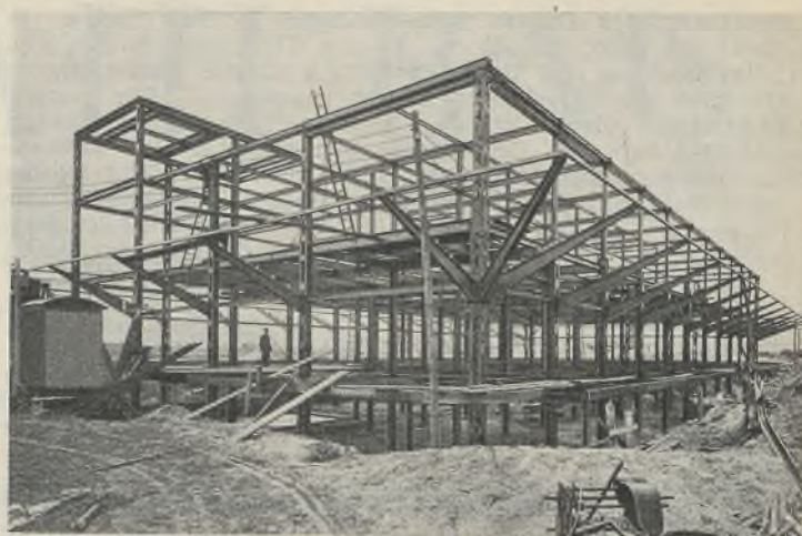
Abb. 4. Beendigung der Montage am 4. August 1930.
