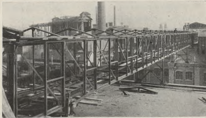
Abb. 2. Stahlkonstruktion der Brücke I, fertig aufgestellt.
