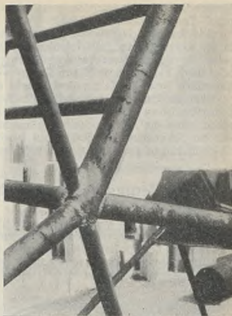
Abb. 11. Geschweißter Knotenpunkt, in dem 6 Stäbe mit rohrförmigem Querschnitt zusammengeführt sind.
