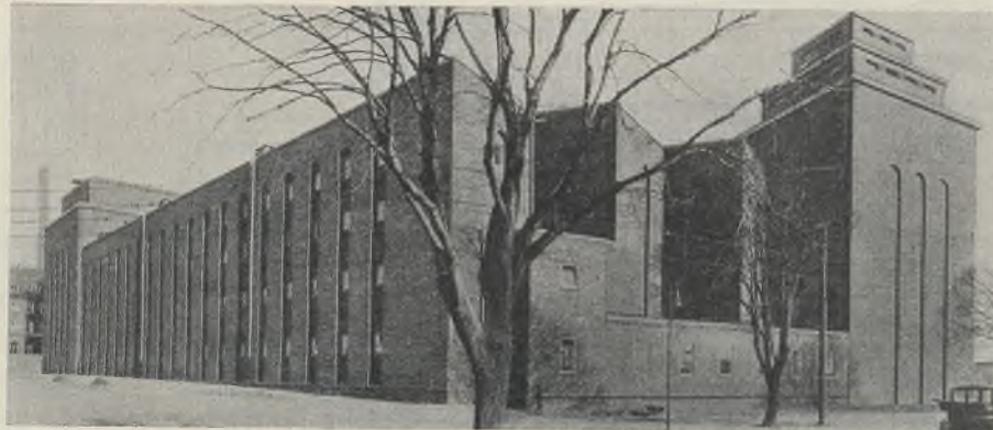
Abb. 15. Das Mälzereigebäude in Berlin-Weißensee.
