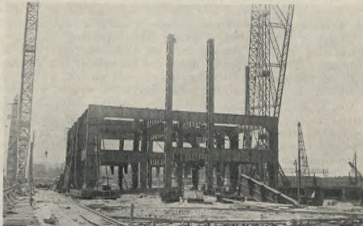
Abb. 18. Mittelstützen über dem Erdgeschoß. 4. August 1929.
