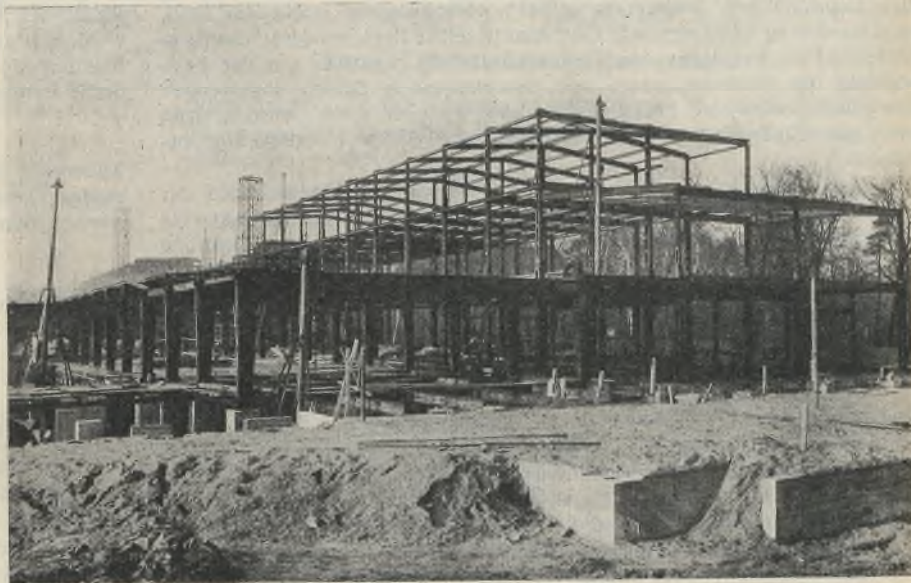
Abb. 13. Montage des 2. Obergeschosses.
