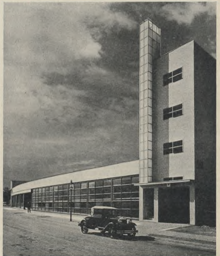
Abb. 2. Frontansicht mit Turm.
