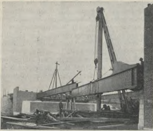
Abb. 18. Billekanal-Brücke; Montage eines Hauptträgers.
