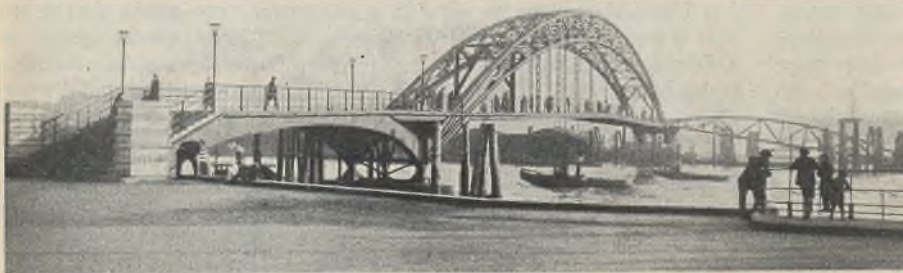
Abb. 6. Die fertiggestellte Überseebrücke.
