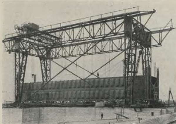
Abb. 2. Hilfsgerüst im fertigen Zustand.
