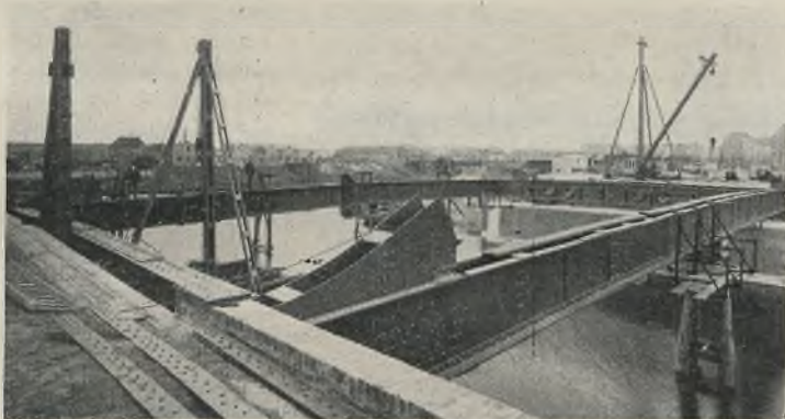
Abb. 19. Billekanal-Brücke; Montage der Querträger.
