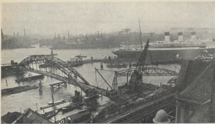
Abb. 5. Einbau der beweglichen Brücke.
