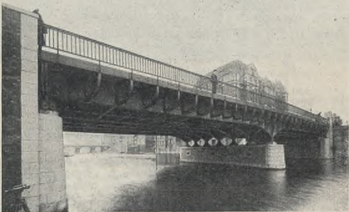
Abb. 14. Billekanal-Brücke im Zuge des Billhornerdeichs.
