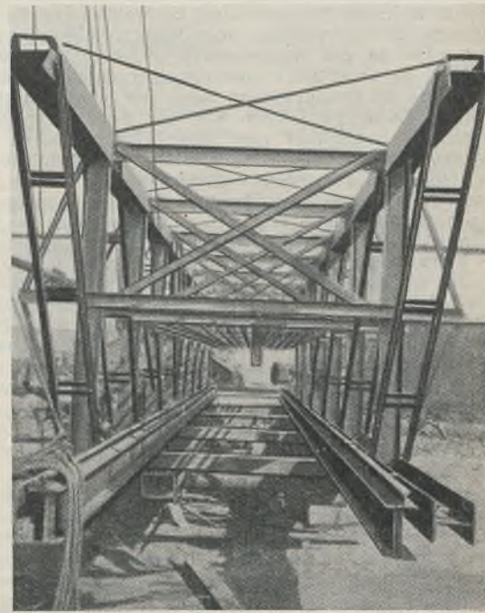
Abb. 2. Querschnitt der Kranbrücke.
