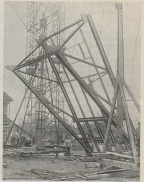
Abb. 5. Aufrichten des Rahmenstieles.
