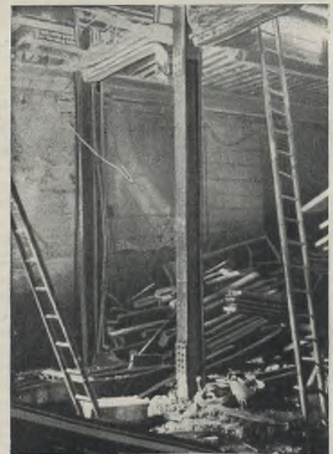
Abb. 13. Ansicht der in kürzester Zeit wieder ordnungsgemäß hergestellten Stütze.
