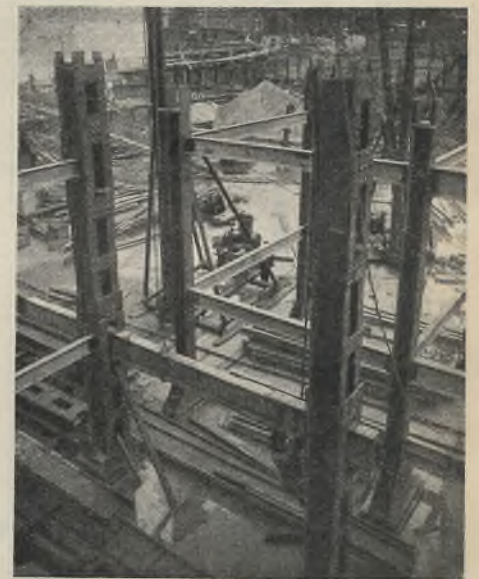
Abb. 46. Montage der Stockwerkrahmen.
