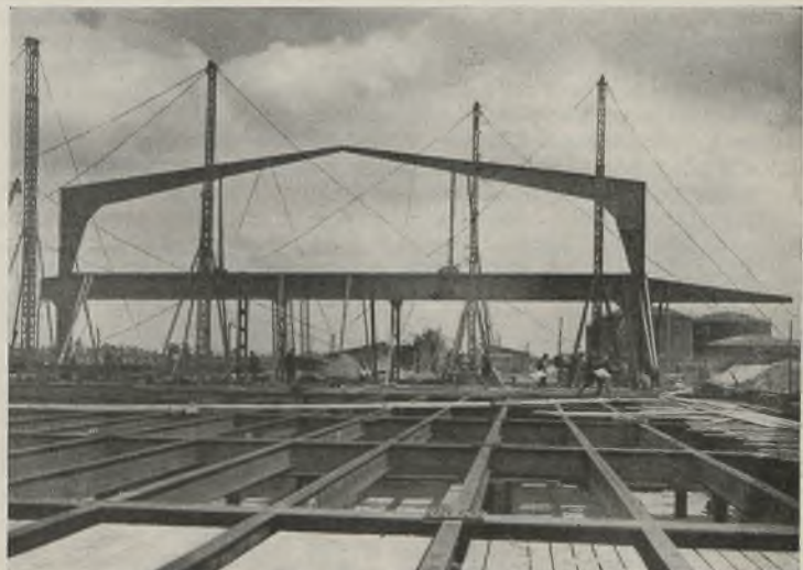
Abb. 6. Montage des Binders 16, dessen Horizontalschub von dem Unterzug aufgenommen wird.
