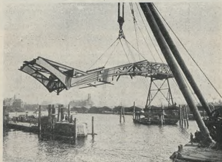
Abb. 3. Überseebrücke: Einsetzen des ersten Bogenstückes.
