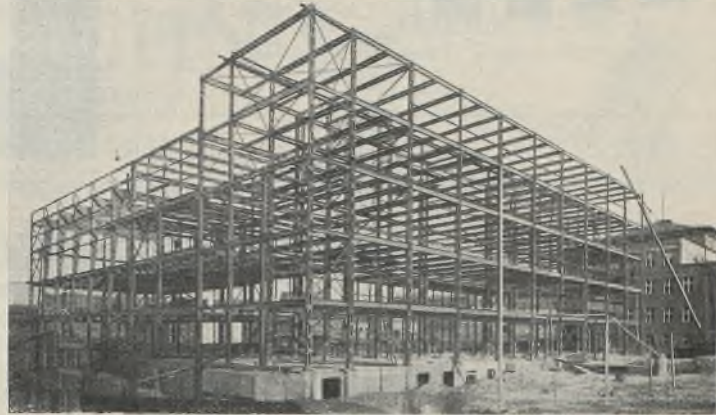
Abb. 5. Ansicht nach beendeter Montage des Stahlskeletts.
