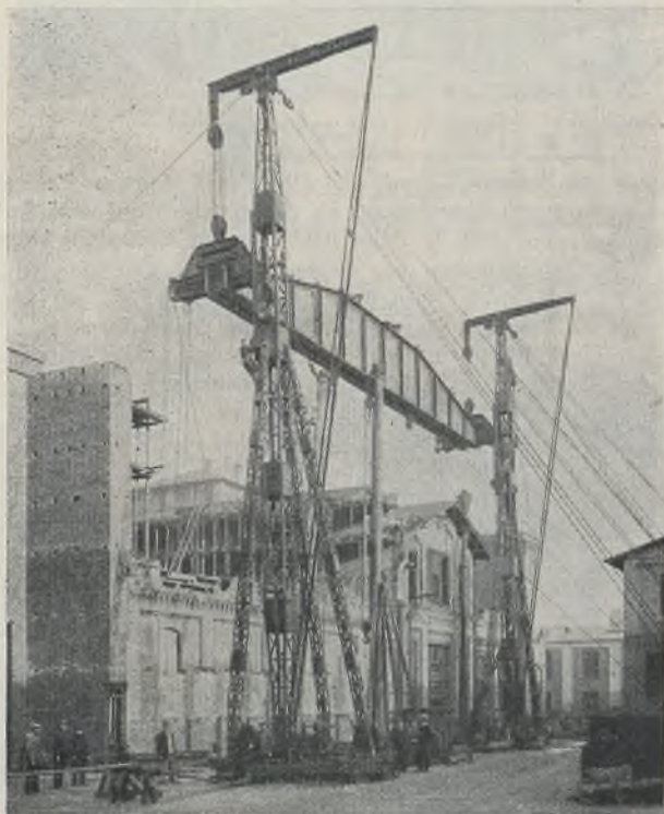
Abb. 10. Binder 14 m hochgezogen.
