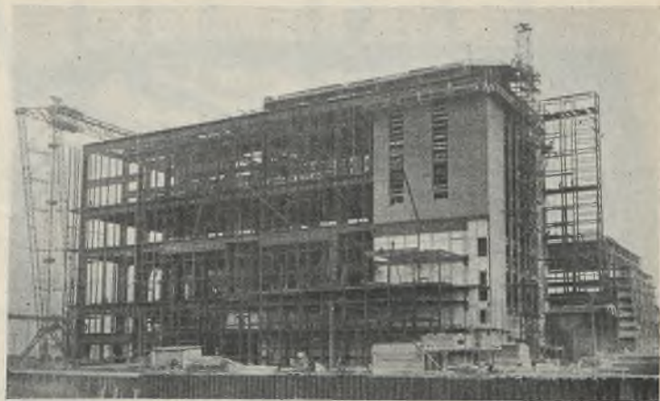
Abb. 22. Kesselhausmontage beendet; Dach und Umfassungsmauern im Bau. 19. November 1929.
