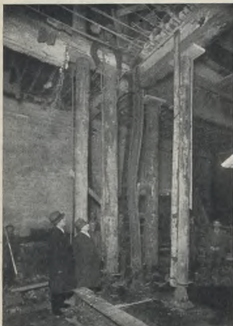
Abb. 9. Vorrichtungen zur Auswechslung der verformten, nicht ummantelten Stahlstütze.
