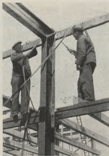
Abb. 6. Anschweißen der Traufpfette.
