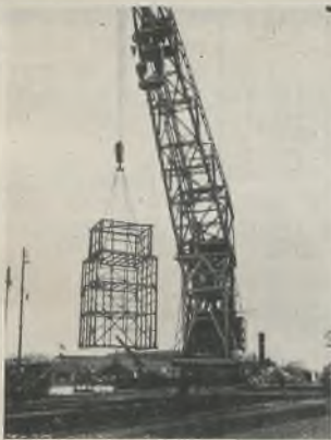
Abb. 3. Transport des gesamten Stahlturmes nach Zusammenbau auf der Kaifläche.
