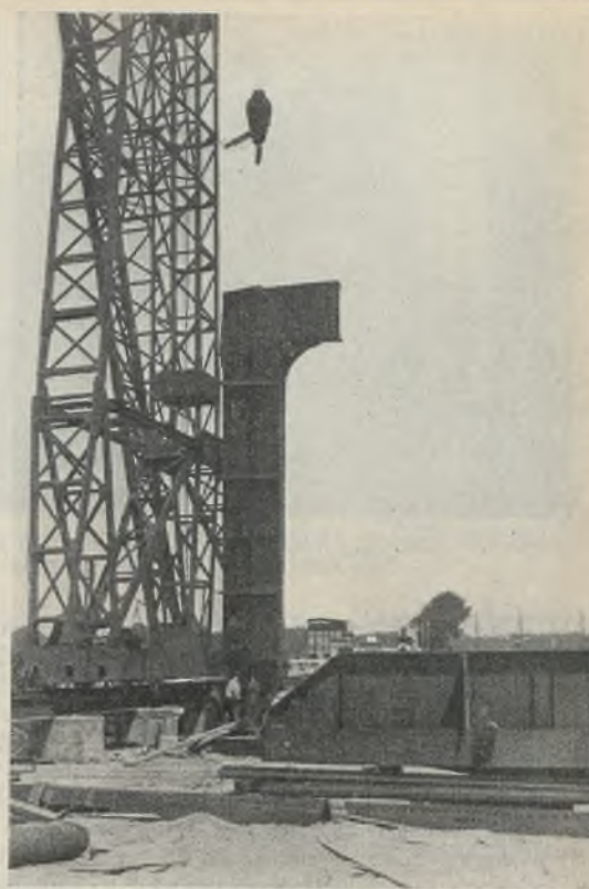
Abb. 16. Beginn der Montage. 10. Juli 1929.
