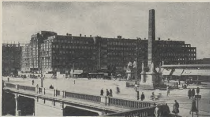
Abb. 20. Geschäftshaus Vesterport, Kopenhagen, der erste Stahlskelettbau Dänemarks.
