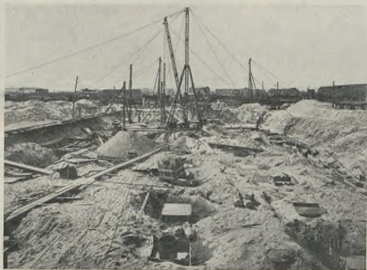
Abb. 3. Baustelle am 21. Juli 1930.
