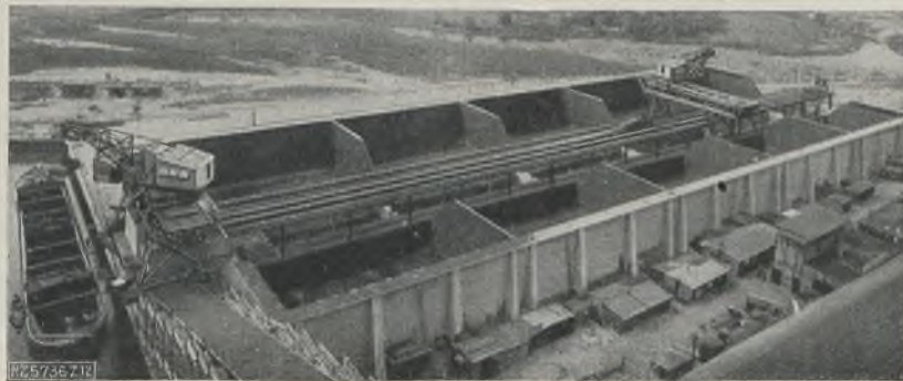
Abb. 2. Außenkohlenbunker des Kraftwerkes; 150 m lang, 50 m breit.
