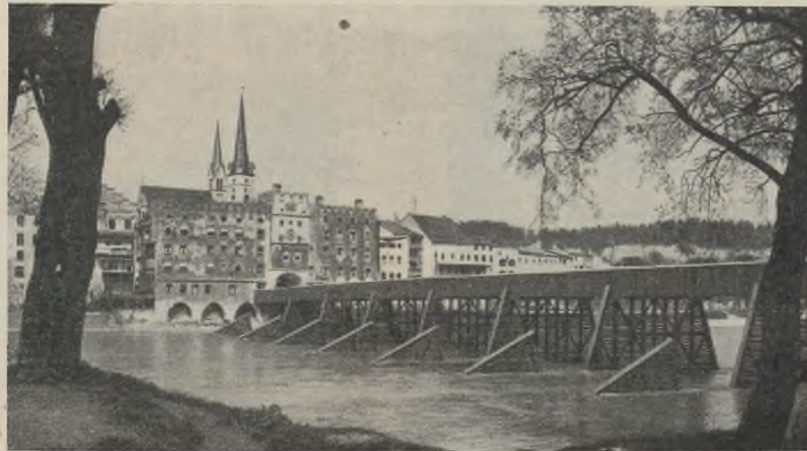
Abb. 9. Blick auf die neue Brücke mit Eisbrechern.
