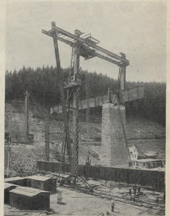
Abb. 6. Beginn der Montage bei Pfeiler (Mitte Juni).
