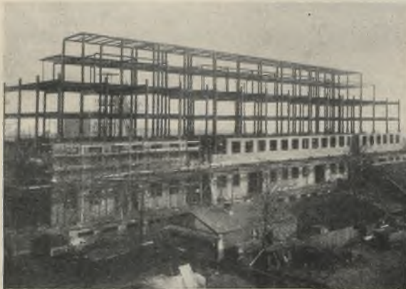
Abb. 17. Stahlskelett des Hauptlagerhauses der Gutehoffnungshütte in Oberhausen.
