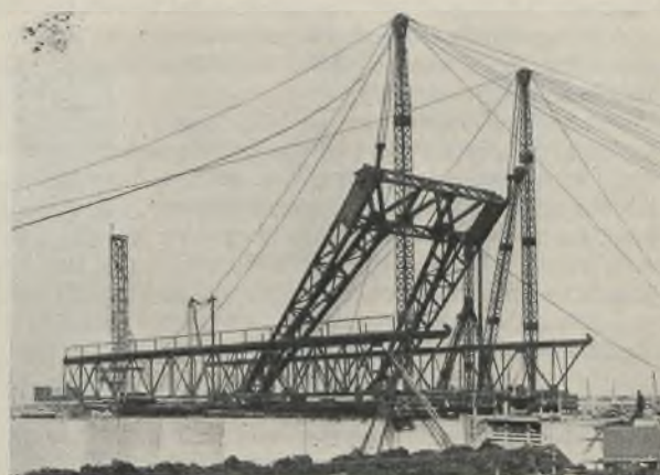
Abb. 3. Aufrichten der Portalrahmen des Hilfsgerüsts.
