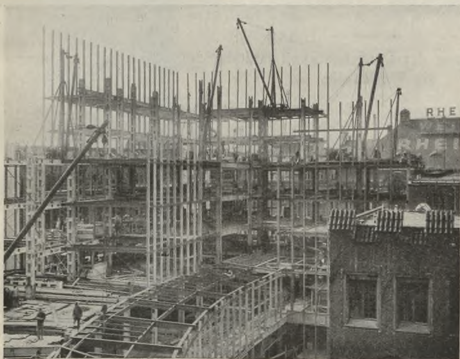
Abb. 14 Montagezustand am 15. September 1931; Montage der inneren Stützen des 7. u. 8. Stockwerks.
