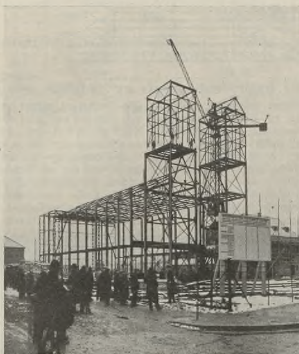
Abb. 7. Aufstellen der Türme. Absetzen des Oberteils über + 18,5 m.
