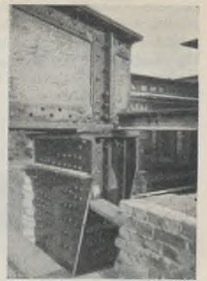
Abb. 9. Wandstützenkopf und Auflager des Doppelbinders.
