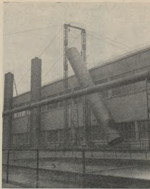
Abb. 8. Drei Behälter, davon zwei fertig aufgestellt. Der dritte wird hochgehoben.
