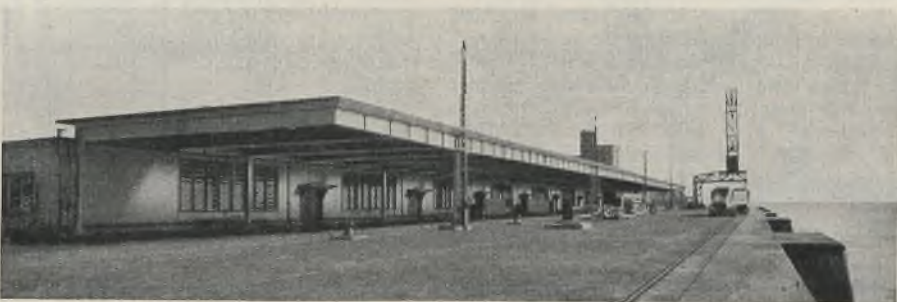
Abb. 3. Klare Linienführung und große Stützweiten kennzeichnen den Aufbau der Überdachung.
