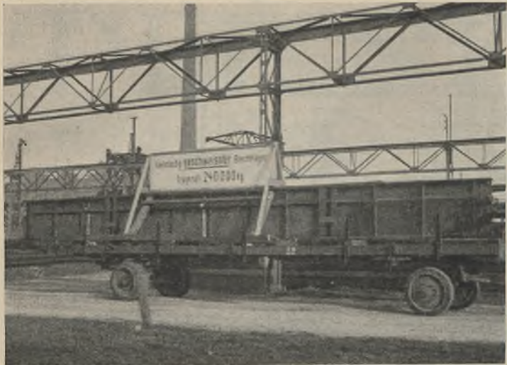
Abb. 5. Versand des Abfangeträgers.
