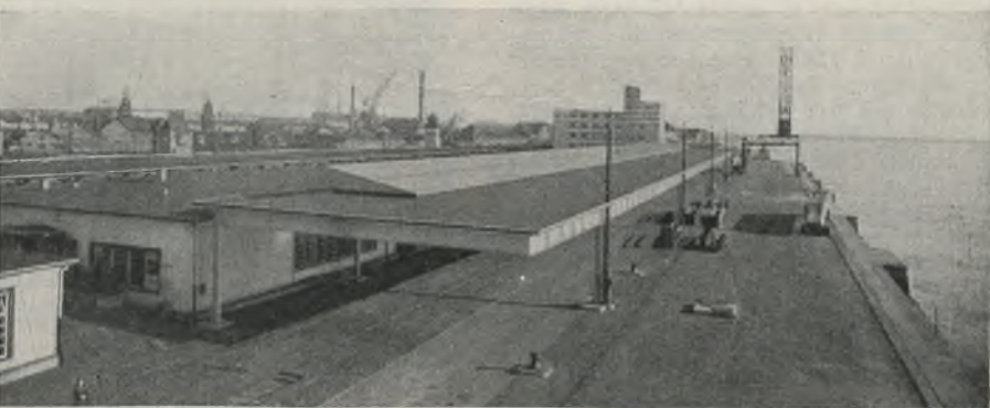
Abb. 4. Ansicht der Oberlichtanordnung der Dachkonstruktion.
