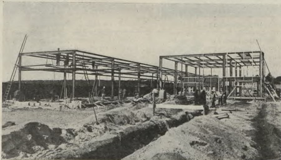
Abb. 1. Montage der „Landwirtschaftlichen Halle“ auf der Bau-Ausstellung, Berlin 1931.
