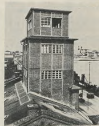
Abb. 5. Turmaufbau nach Fertigstellung.
