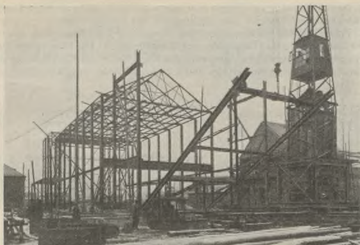
Abb. 6. Aufstellen der Türme. Aufrichten der Wand c.
