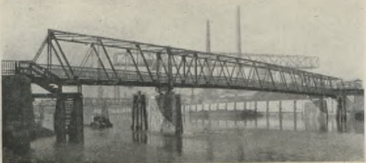
Abb. 10. Ansicht der fertiggestellten Brücke.
