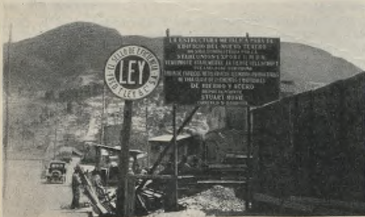
Abb. 7. Ansicht der unvorbereiteten Baustelle.
