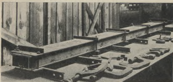
Abb. 6. Stützenschaft, zusammengeklemt und vorgezogen.
