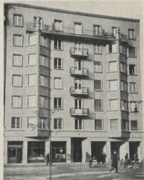
Abb. 11. Das fertiggestellte Wohnhaus.
