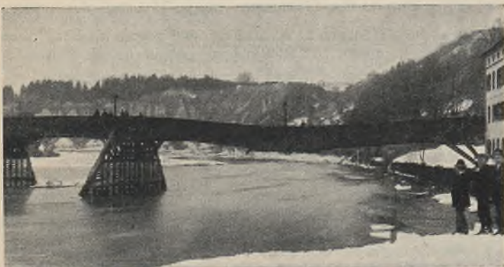
Abb. 2. Durchgang der alten Brücke mit weggerissenem Joch.
