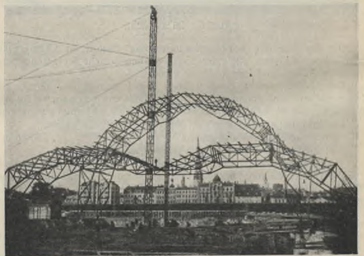
Abb. 6. Montage der Markthallenbinder.
