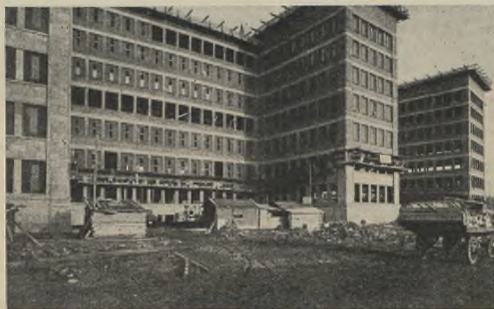
Abb. 10. Kurz vor der Beendigung der Ausfachung.
