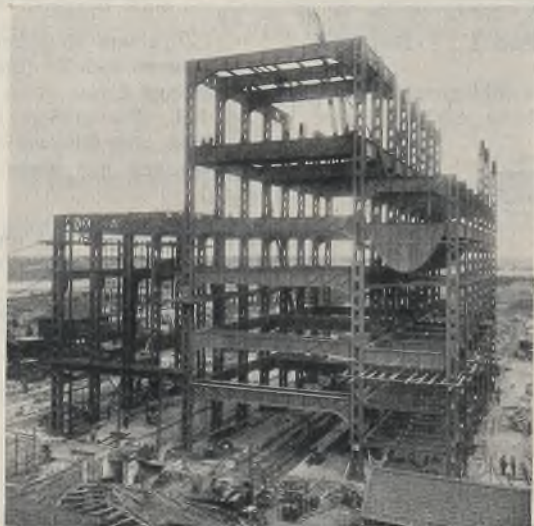
Abb. 1. Das Stahlskelett kurz vor der Vollendung.
