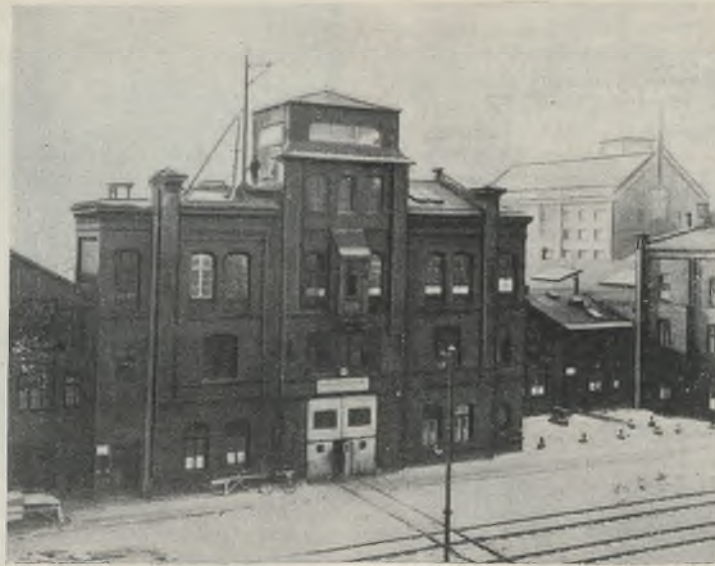
Abb. 1. Werkstattgebäude vor dem Umbau.
