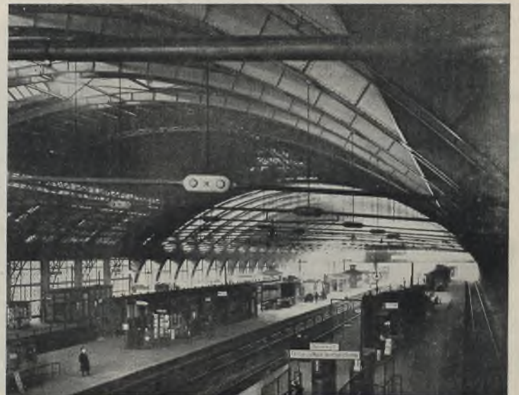
Abb. 3. Nördliche Bahnsteighalle Schlesischer Bahnhof nach teilweiser Erneuerung (Hallen-Mittelstück zeigt noch die alte Dachkonstruktion).
