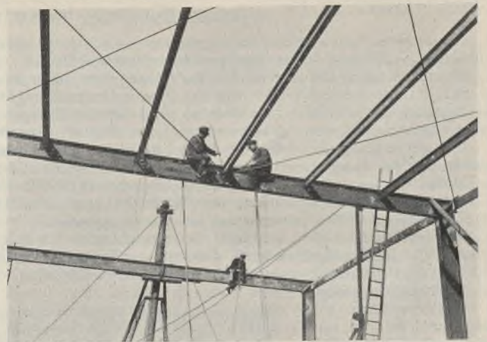
Abb. 5. Doppelseitiges Einschweißen der Pfetten.
