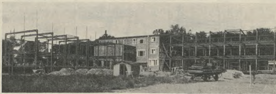
Stahlkonstruktion der Missionsanstalt Groß-Krotzenburg a. M.
