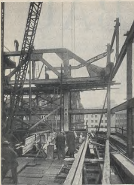
Abb. 3. Montage des Fachwerk-Kragträgers im 5. u. 6. Obergeschoß.
