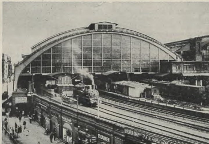
Abb. 4. Westliche Hallenschürze der neuen Nordhalle des Schlesischen Bahnhofs.
