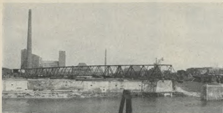
Abb. 8. Fertig zusammengebaute Brücke vor der Verschiebung.
