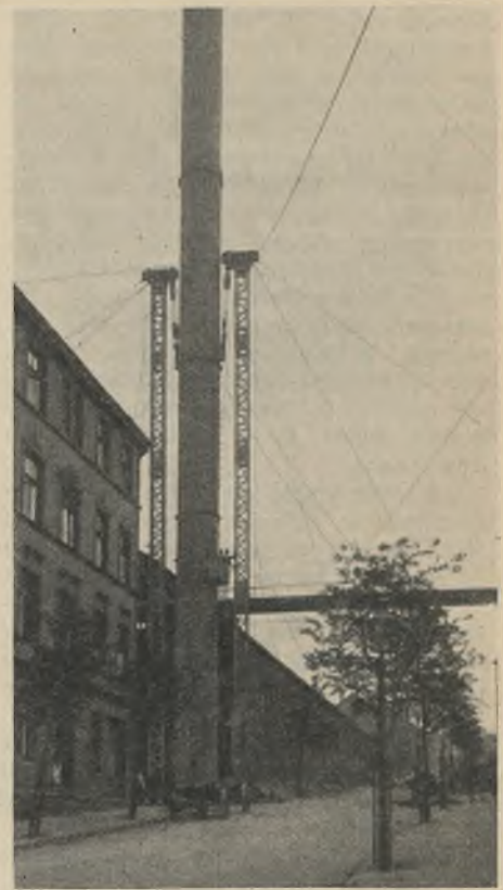
Abb. 7. Stahlblechkamin 42 m hoch.
