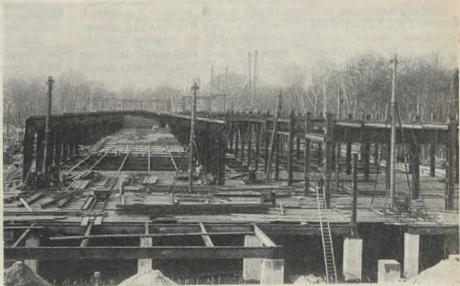
Abb. 12. Montage der Rahmen mit Hilfe von Standbäumen.
