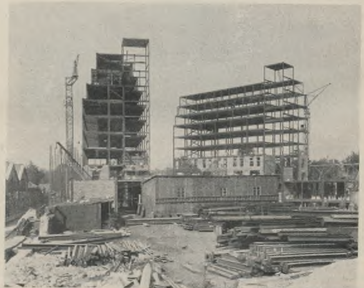
Abb. 16. Montagebild vom Bau eines Pariser Verwaltungsgebäudes.
