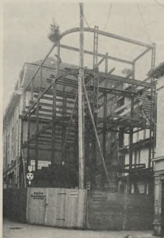
Abb. 1. Stahlskelettbau Garau, Kissingen.
