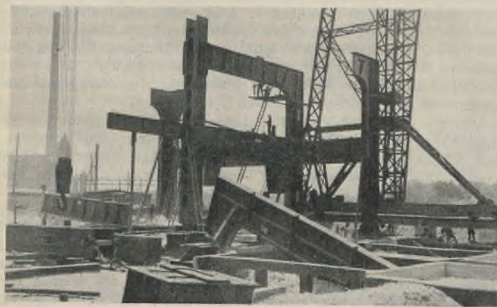
Abb. 17. Querrahmen mit Gelenk an der Mittelstütze. 14. Juli 1929.
