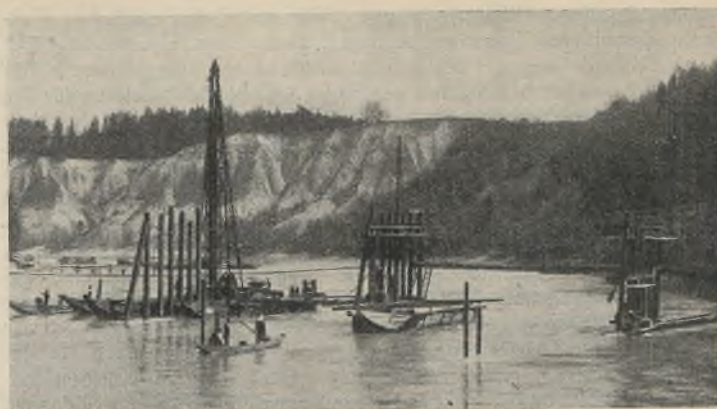
Abb. 7. Schwimmende Ramme bei der Arbeit.
