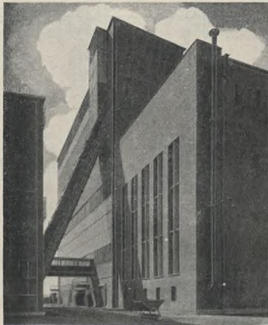
Abb. 12. Außenansicht des Maschinen- und Kesselhauses.
