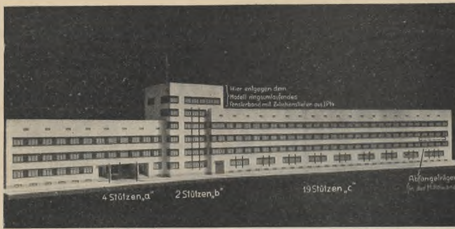
Abb. 1. Modellaufnahme der Polizeiunterkunft in Berlin-Cöpenick (Straßenseite) mit Eintragung der geschweißten Stützen und Träger.
