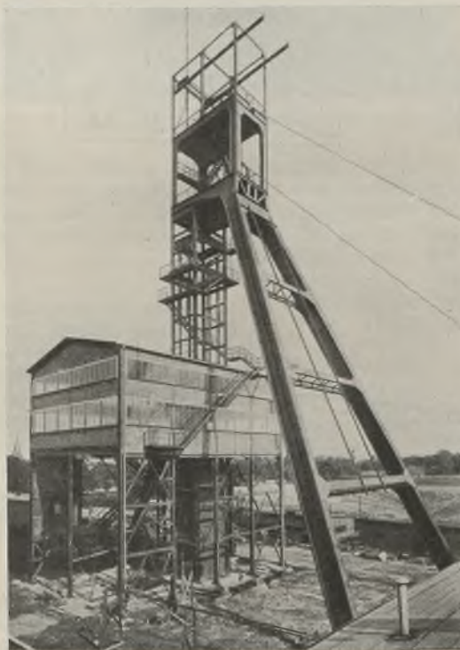
Abb. 5. Gesamtansicht des Fördergerüsts Miechowitzschacht.
