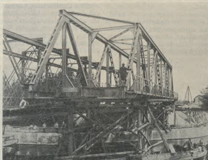
Abb. 27. Blick auf die Brücke über den Elbe-Trave-Kanal nach der ersten Verschiebung.
