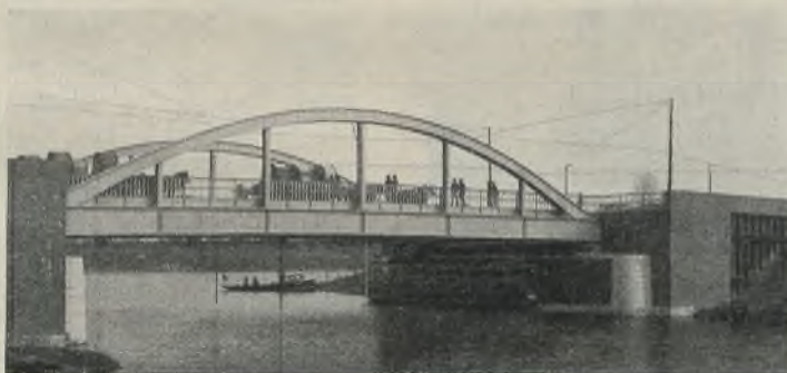
Abb. 20. Billekanal-Brücke im Zuge der Großmannstraße.
