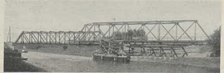
Abb. 26. Eisenbahnbrücke über den Elbe-Trave-Kanal; nach der ersten Verschiebung der Brücke.
