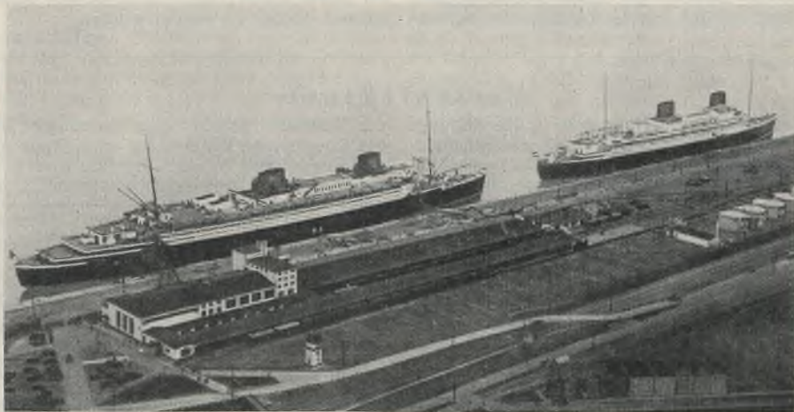
Abb. 1. Blick auf die Zollabfertigungsgebäude mit noch nicht überdachter Kai-mauer und auf die „Bremen“ und „Europa“.
