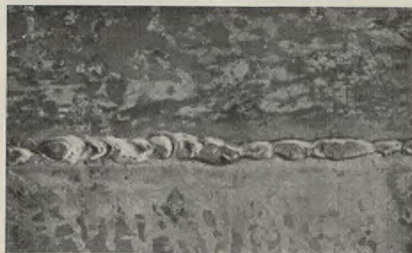
Abb. 4. Die Scheitelseite der V-Naht (Spitze) von etwa 100 mm Länge zeigt guten Durchfluß.
