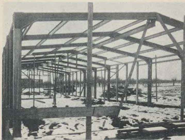
Abb. 1. Die Stahlkonstruktion des Neubaus.
