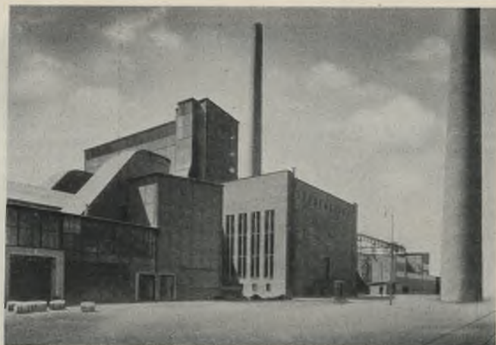
Abb. 2. Gesamtansicht der Anlage.
