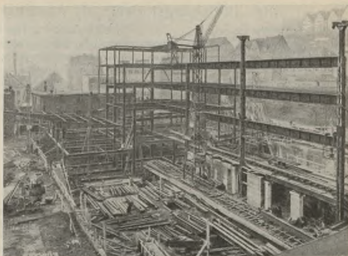
Abb. 7. Als Montagegerät bewährt sich hier der Turmdrehkran.
