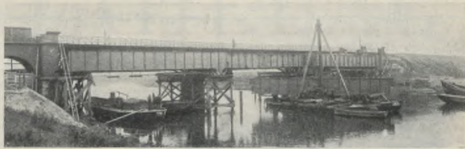
Abb. 22. Auswechslung der Eisenbahnbrücke über die Bille; der letzte Hauptträger wird hochgezogen.
