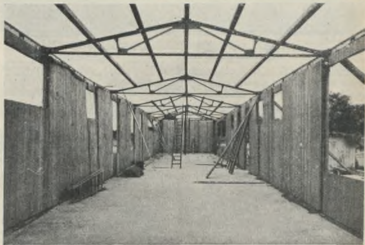
Abb. 7. Innenaufnahme einer Baracke während des Baues.
