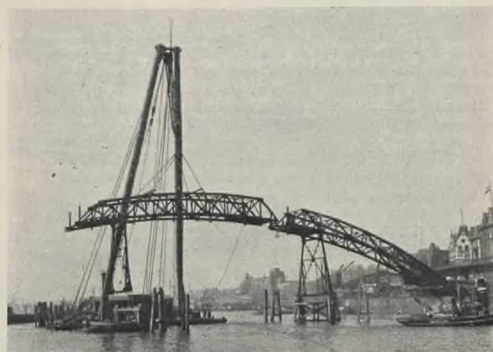
Abb. 4. Montage des zweiten Bogenstückes.
