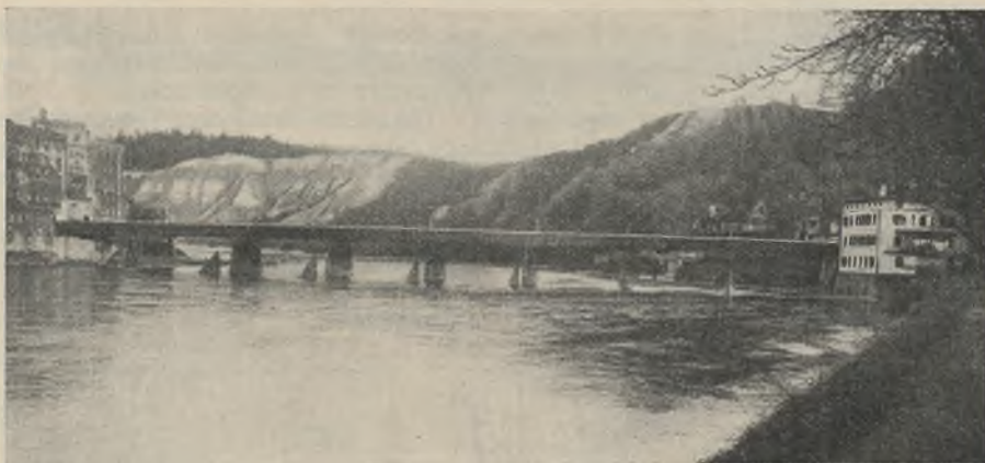
Abb. 10. Gesamtansicht der neuen Brücke.
