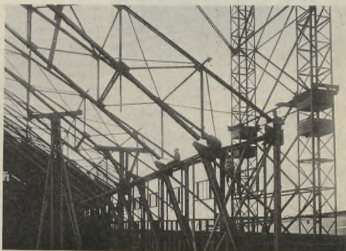
Abb. 3. Der hochgezogene Teil wird angeschlossen.
