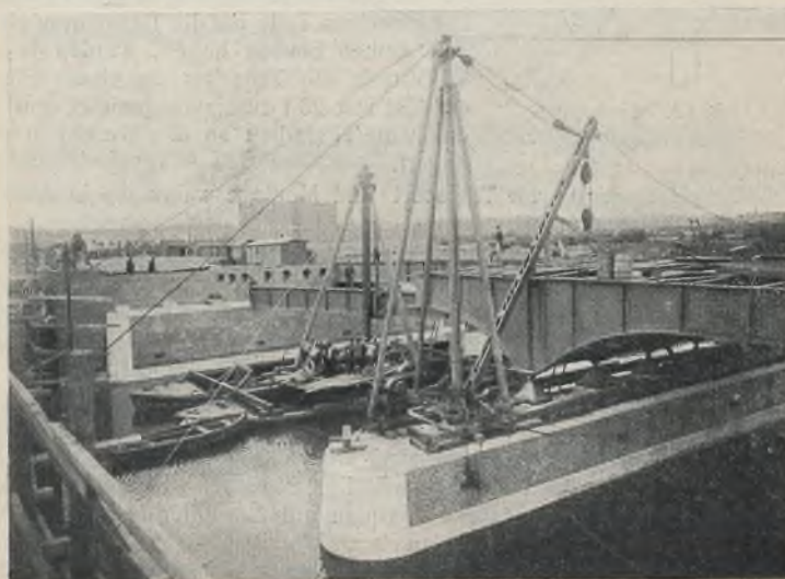
Abb. 15. Gustav-Kunst-Straßenbrücke über die Bille; Montage.
