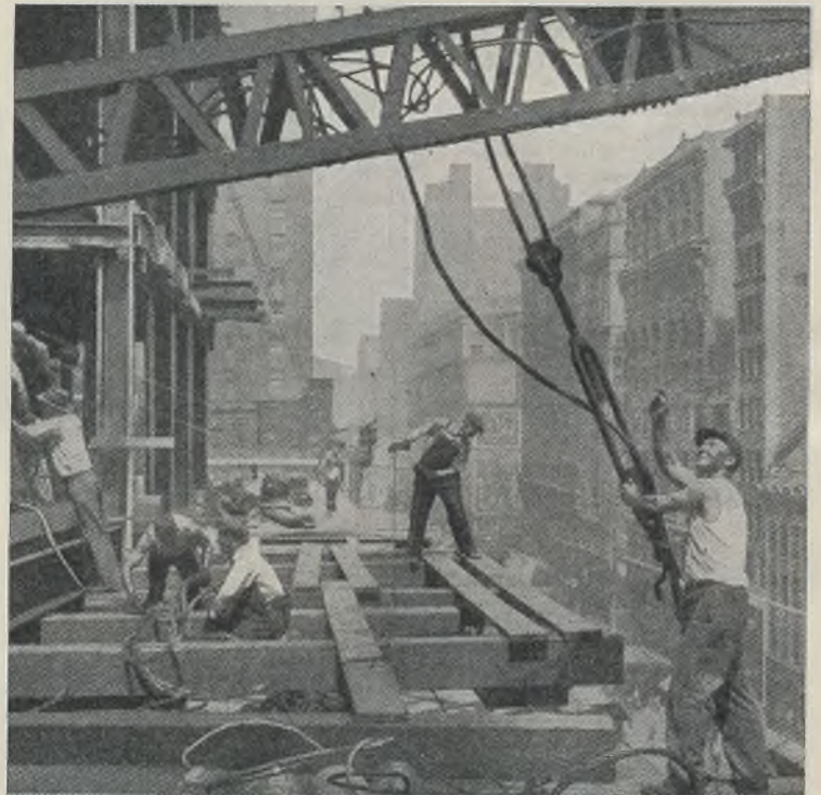
Abb. 3. Auskragende Plattform für den Aufzugkran.
