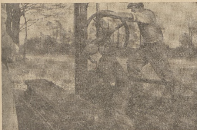
Zmechanizowano wydobywanie torfu opałowego
