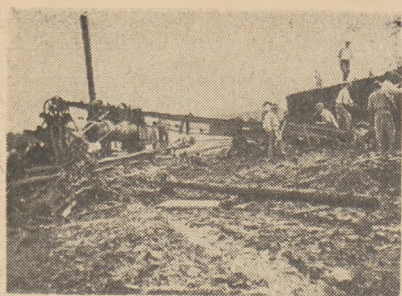
Podajnik dostarcza masę torfową do mieszarki, skąd wychodzą już sprasowane cegielki
