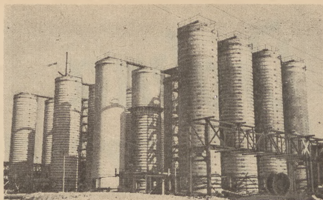
Uruchomienie Kędzierzyna i setek innych fabryk i zakładów przemysłowych byłoby niemożliwe bez pomocy naszych radzieckich przyjaciół. Na zdjęciu wieże absorbcyjne kwasu azotowego
