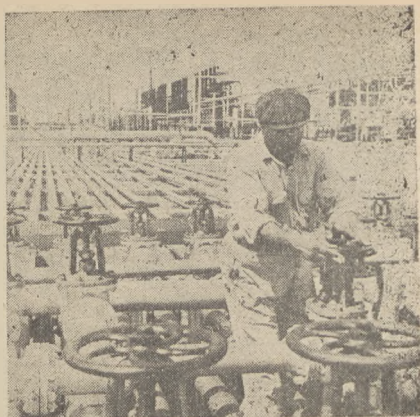
Regulacja przepływu ropy między zbior- nikami a rafinerią.
