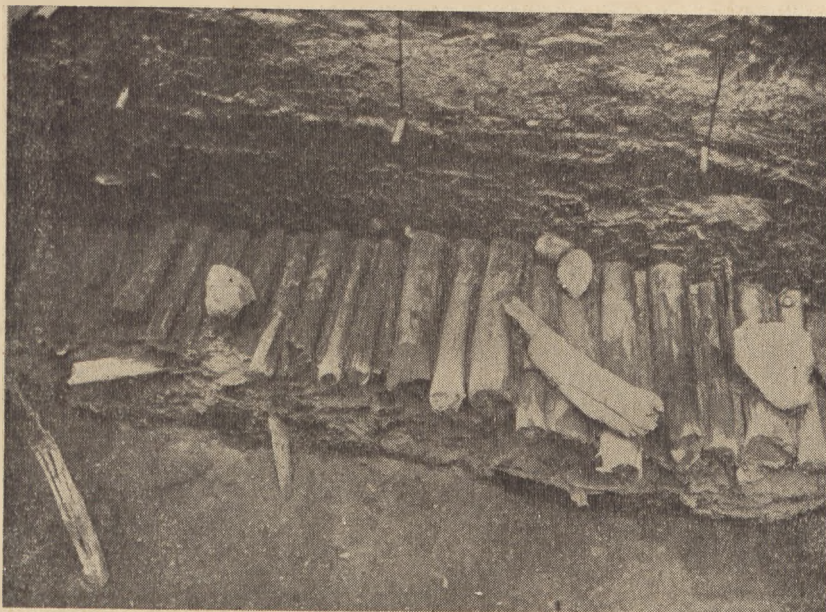
Gniezno — Góra Lecha Ar 10, warstwa II c — droga wykładana belkami.
