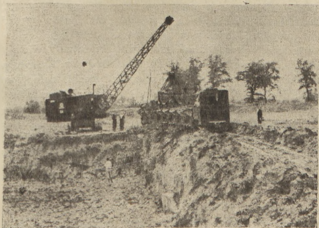
Zapora wodna w Goczałkowicach w budowie
