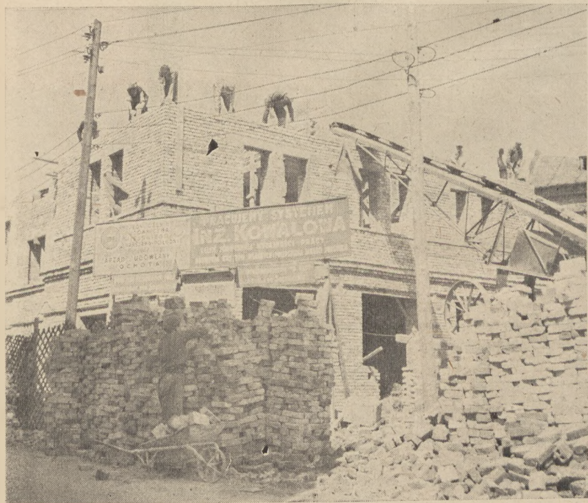
Murarze pracują metodą Kowalewa przy budowie osiedla warszawskiego na Ochocie
