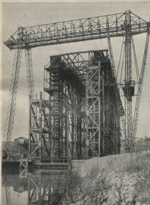
Abb. 1. Der Montagekran im Betrieb bei der Aufstellung der Stahlkonstruktion (Sept. 1931). Teile der Hilfsbrücke als Montagehilfsverband zwischen den Rahmenstielen des Hebewerkerüstes.
