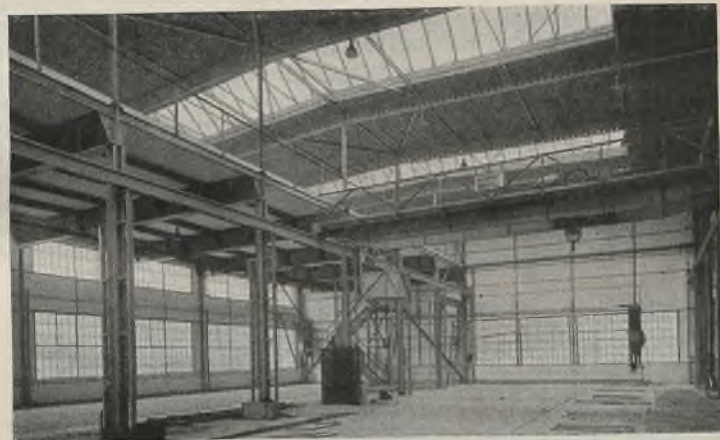
Abb. 2. Vollständig geschweißtes Werkstattgebäude.
