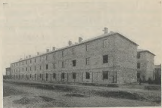
Abb. 10. Ansicht der unverputzten Wohnhäuser.
