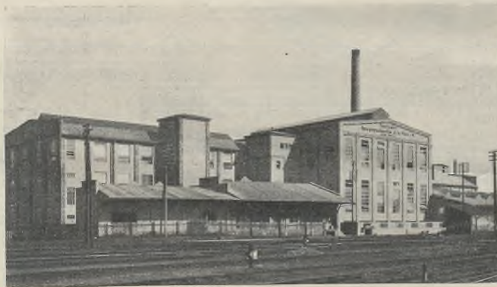
Abb. 5. Ansicht der Schneide- und Maschinenhalle.
