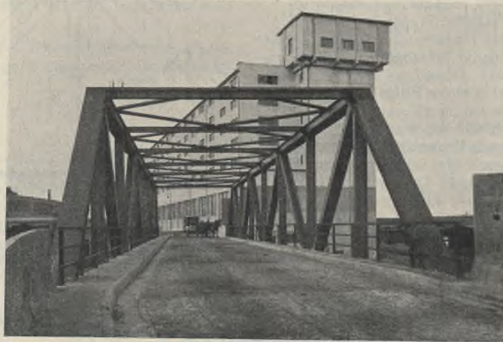
Abb. 6. Blick in die fertige Brücke.
