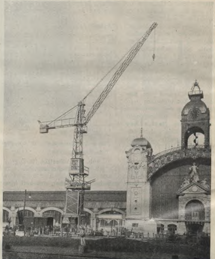
Abb. 7. Vollständig geschweißter Baukran.
