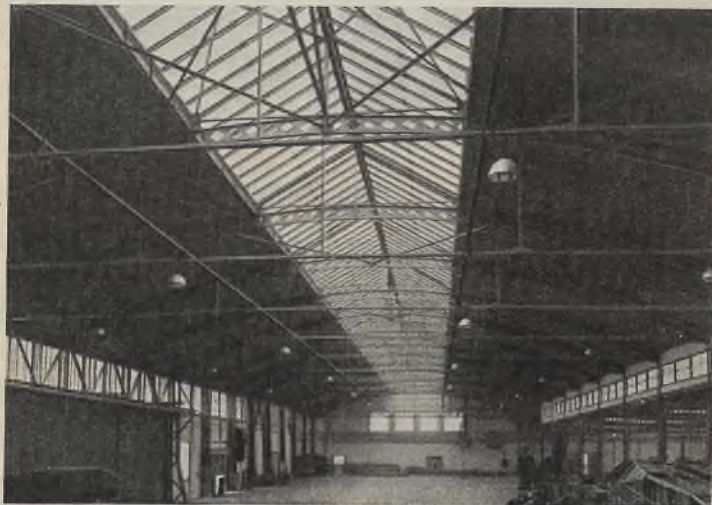
Abb. 6. Vollständig geschweißte Montagehalle in Prag.
