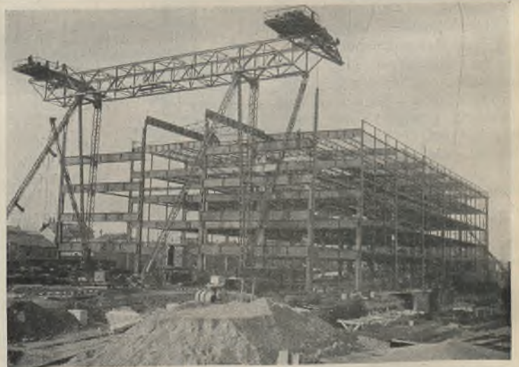
Abb. 10. Montage der Stahlkonstruktion.
