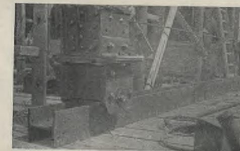
Abb. 2. Ein Teil der Verschiebbahn mit dem am Binderfuß befestigten Wagen.
