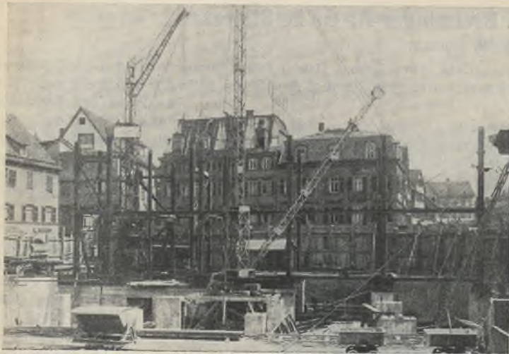
Abb. 6. Montage des Stahlskeletts.
