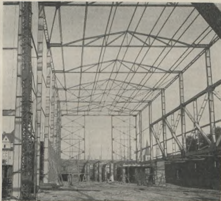
Abb. 6. Das Stahlskelett im fertigen Zustand.
