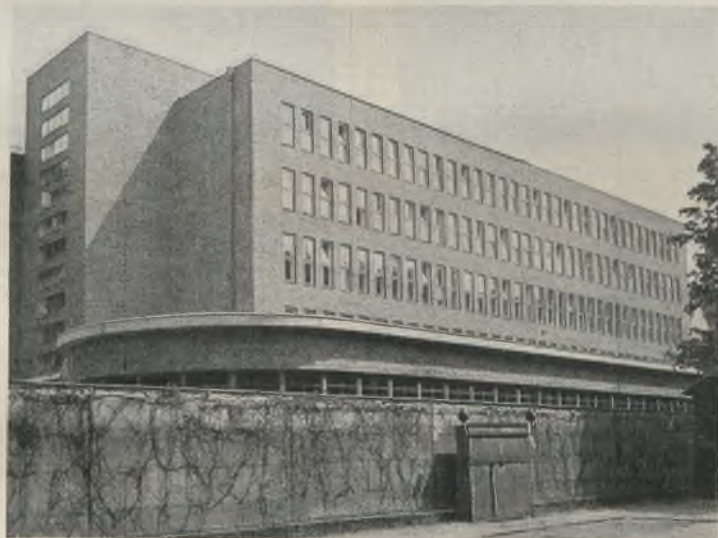
Abb. 9. Ansicht des fertiggestellten Gebäudes.
