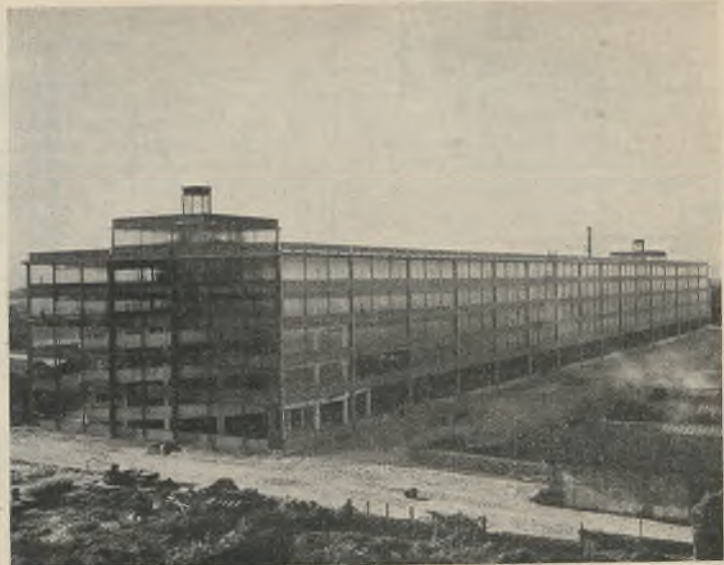
Abb. 12. Ansicht des Gebäudes.
