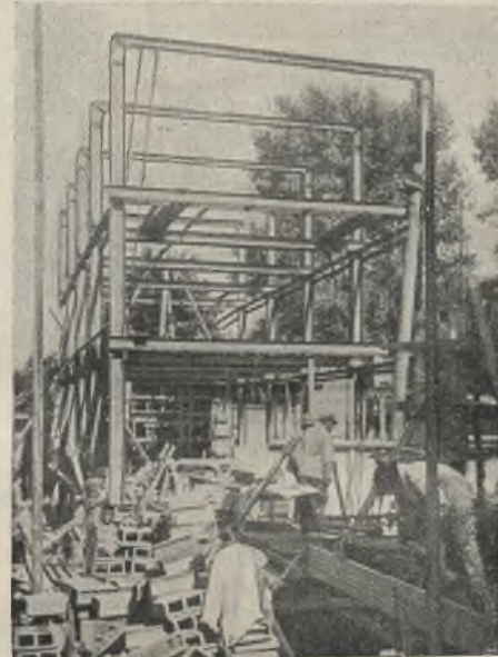
Abb. 1. Aufstellung des Stahlskeletts.
