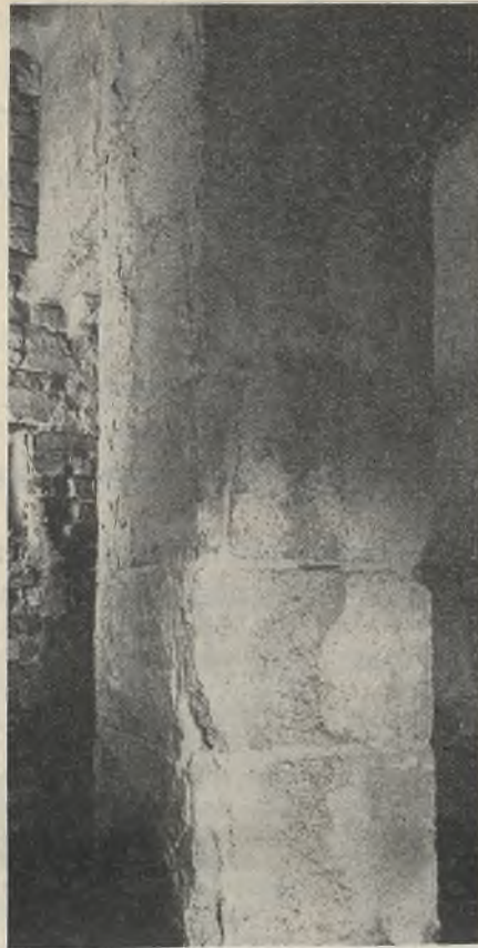
Abb. 5. Der äußere Mantel der Versuchsstücke Ausführung 2 und 3 in Gruppe B nach dem Ablöschen.
