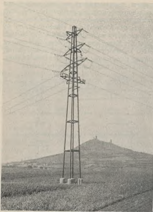
Abb. 6. Abspann-Abzweigmast.
