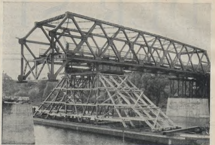
Abb. 4. Einfahren der an Land zusammengebauten Mittelöffnung und einer Seitenöffnung mit Hilfe eines Oderkahnes.
