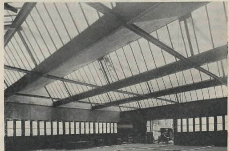
Abb. 5. Blick in die Halle.
