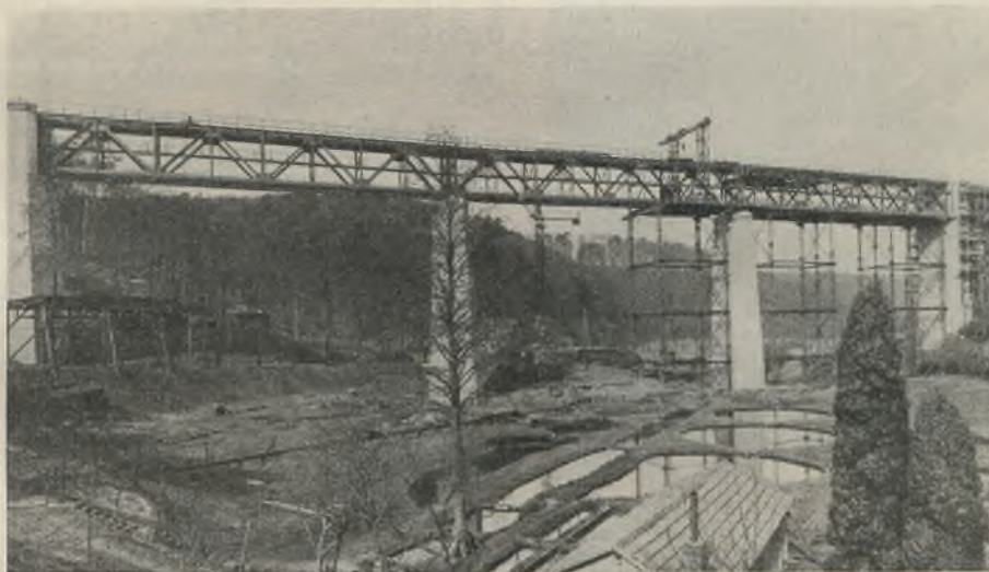
Abb. 1. Bau der Eistalbrücke.
