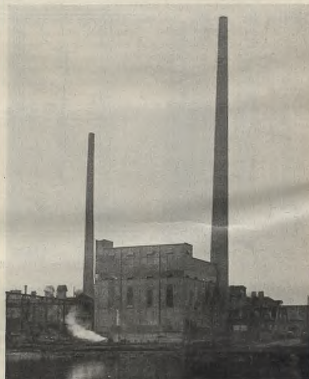
Abb. 4. Das Kesselhaus nach dem Umbau.
