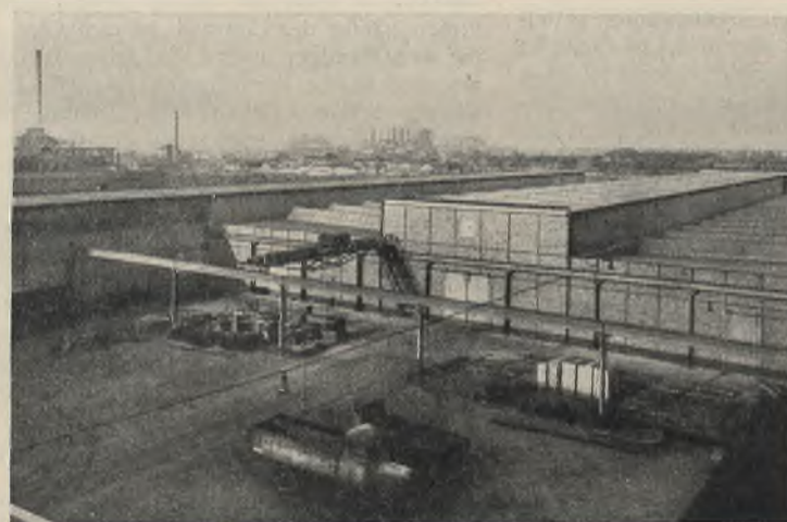
Abb. 8. Hof zwischen Verwaltungsgebäude und Fabrik.
