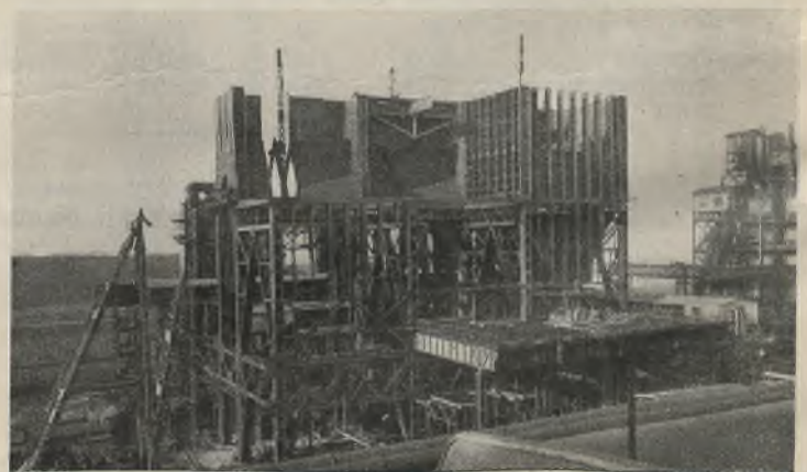
Abb. 17. Montage der Bunker mittels Ausleger-Kranen.
