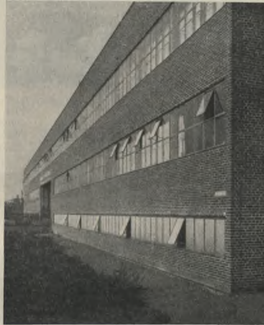
Abb. 12. Front des Verwaltungsgebäudes.
