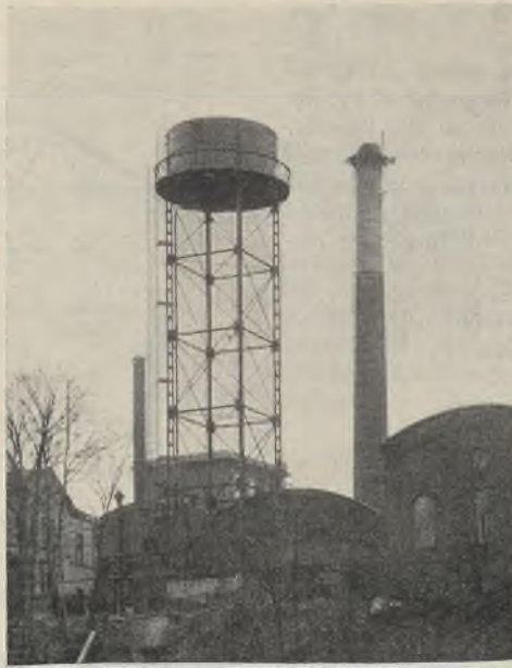
Abb. 3. Wasserbehälter für Zeche Heinrich, Überruhr.
