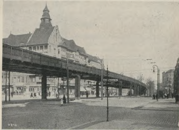
Abb. 3. Hochbahnviadukt in der Schönhauser Allee, Berlin.
