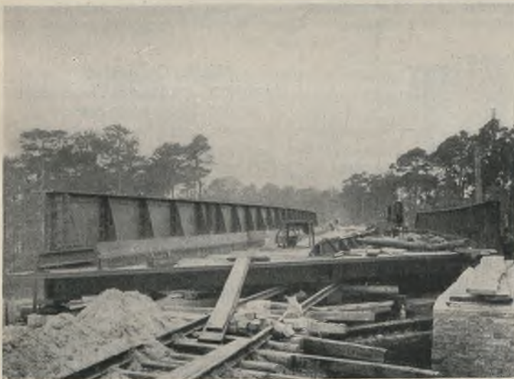
Abb. 2. Straßenunterführung am Bahnhof Ruhleben d. Berliner Hochbahn.
