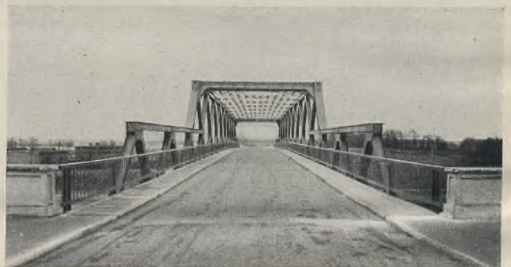
Abb. 6. Durchblick durch die neue Oderdeichbrücke.
