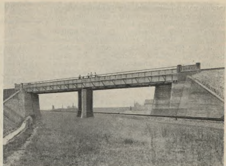
Abb. 10. Brücke am Bahnhof Neu-Bentschen.
