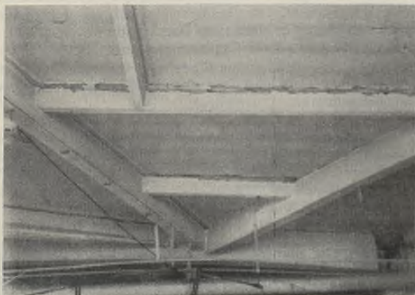
Abb. 7. Die auf den mit Rabitz ummantelten I-Trägern liegende Leichtsteindecke ist nicht in die alte Lage zurückgefallen.
