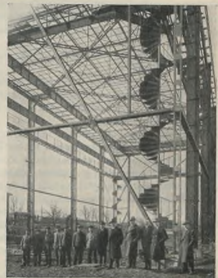
Abb. 3. Das Stahlskelett nach beendeter Montage.
