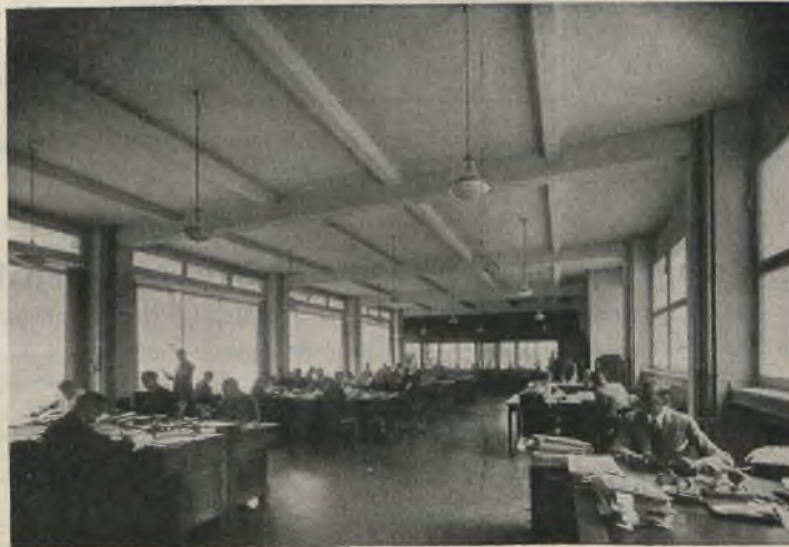
Abb. 1. Büroraum im II. Stock. Beachtlich der Verzicht auf ebene Deckenunteransicht.)
