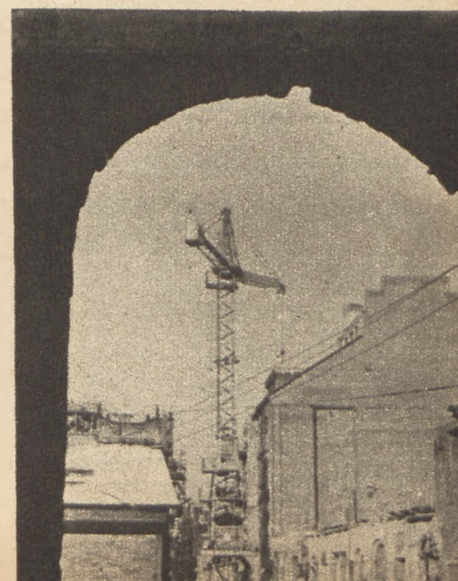
Dźwig stoi po stronie Barsa. Oddaje nieocenione usługi w odbudowie „Starówki“
