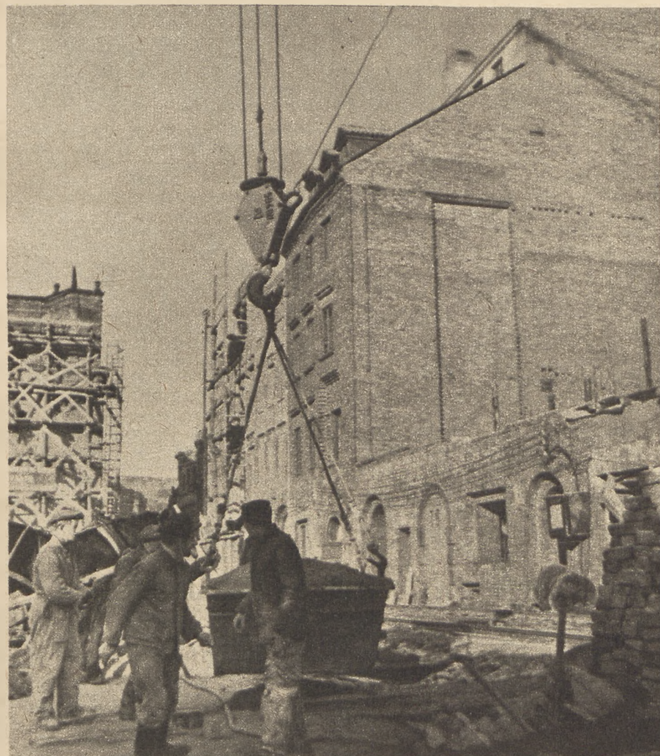
Zabytkowy Rynek powstaje z ruin i zgłiszcz. Dzięki codziennej wyteżonej pracy budowniczych Warszawy, nowa wizja Starego Miasta nabrała już realnego kształtu.
