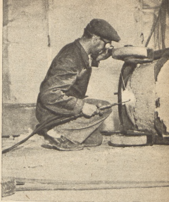
Przy odbudowie zakładów od początku pracował spawacz Kaczmarek.
