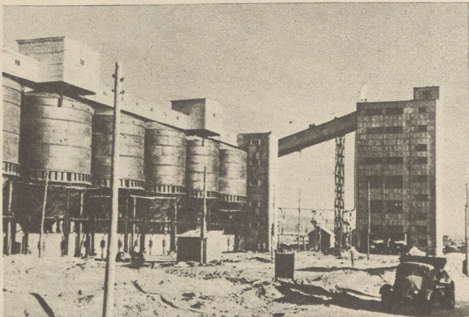
CAF Na jednym z odcinków budowy Kujbyszewskiej Elektrowni Wodnej czynne są mechaniczne betoniarnie, obsługiwane przez niewielką wykwalifikowaną załogę.
